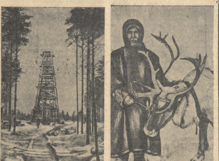
В таких местах Верхне-Таврической области (Свердловская область), еще недавно безлюдных и глухих, теперь полным ходом идет разведочная работа на нефть. На снимке: первая буровая вышка Верхне-Таврической разведочной партии Наркомнефти.
