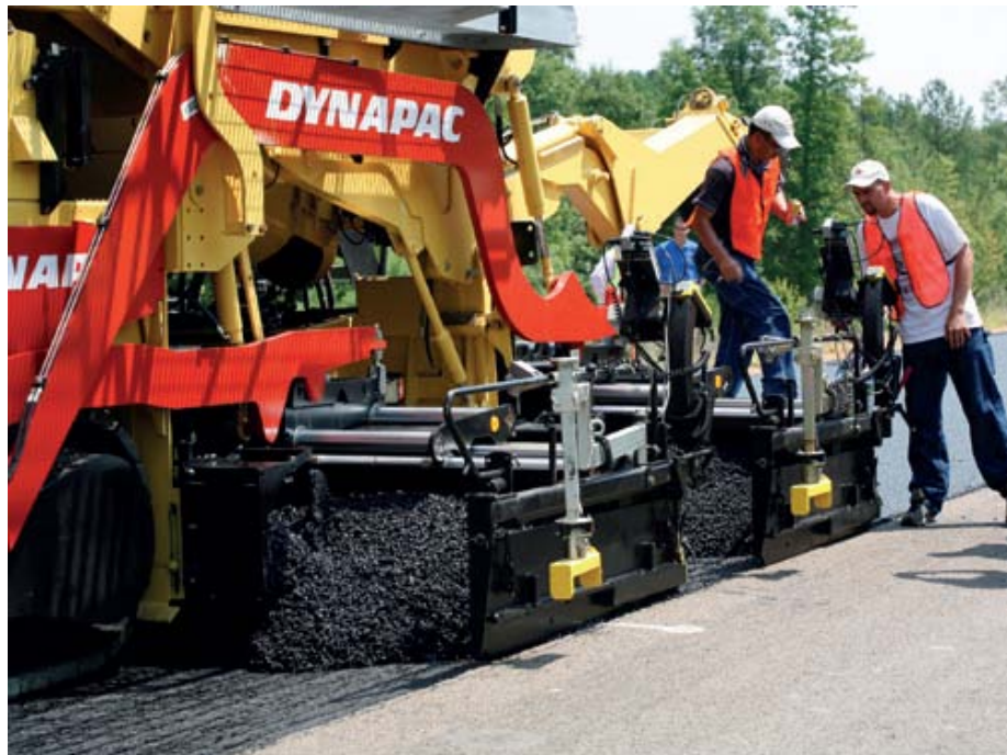
ნახ. 25. ერთი ასფალტდამგებით ასფალტბეტონის ორი ფენის ერთდროულად მოწყობა
