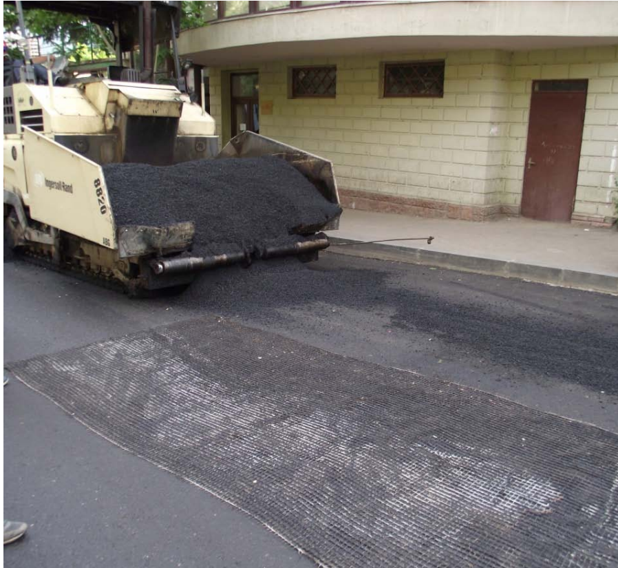
ნახ. 42. ასფალტბეტონის ქვედა ფენაზე დაფენილი ბაზალტის ბადე
