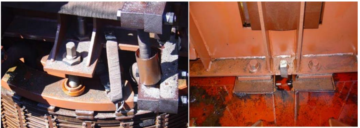
ნახ N°4 მყარი მინარევი ტრანსფორმატორის აქტიური ნაწილის ზედაპირზე
