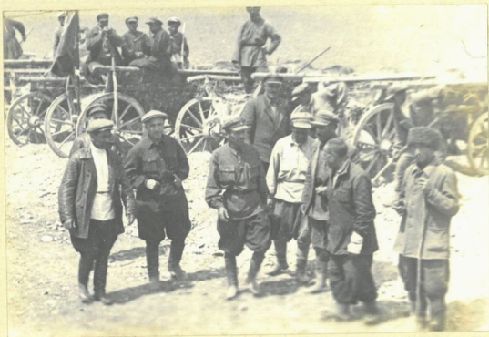
РАЙШТАБ ОБХОДИТ СТРОИТЕЛЬСТВО ДОРОГ
