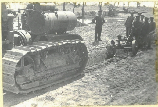
МЕХАНИЧЕСКАЯ КОПКА КЮВЕТОВ [КАНАЛ]
