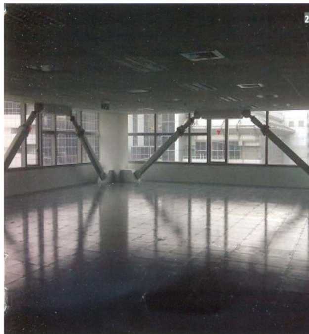
ნახ.13. განმბრჯენი დაყენებული ჰიდრაულიკური დემპფერებით
