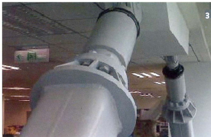
ნახ.11. გამბჯენში ჩამონტაჟებული ჰიდრაულიკური დემპფერის დეტალი
