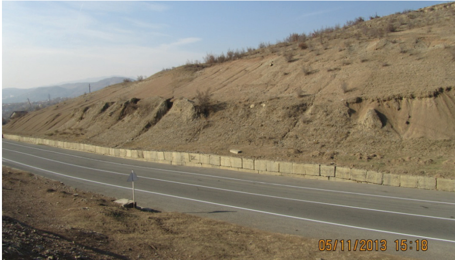
ფოტო 1. “ტრასეკას“ სატრანსპორტო ღერეფნის სოფ. გლდანის მონაკვეთზე არსებული მოწყვლადი ფერდობი
