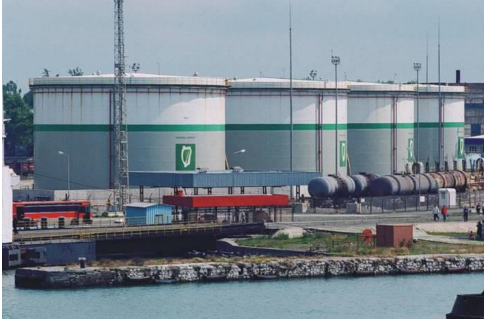
ნახ. 25. კომპანია “Channel Energy Poti LTD“-ს I ფაზის სარეზერვუარო პარკი
