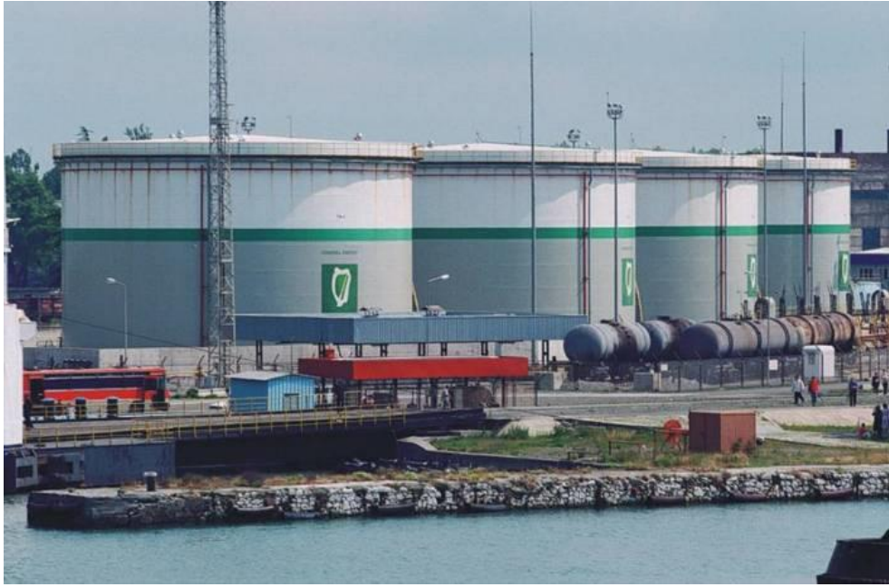
ნახ. 10. კომპანია “Channel Energy Poti LTD“-ს I ფაზის სარეზერვუარო პარკი
