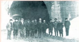
1979-80 წლის ზამთარი — ფოტოზე გვირაბის ჩრდილო პორტალიდან „თბილგვირაბმშენის“ ხელმძღვანელებისა და მშენებელი კატუფია აღბეჭდილი
