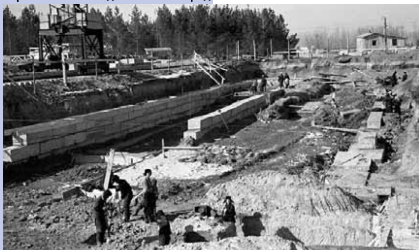
Строительство Академического городка
