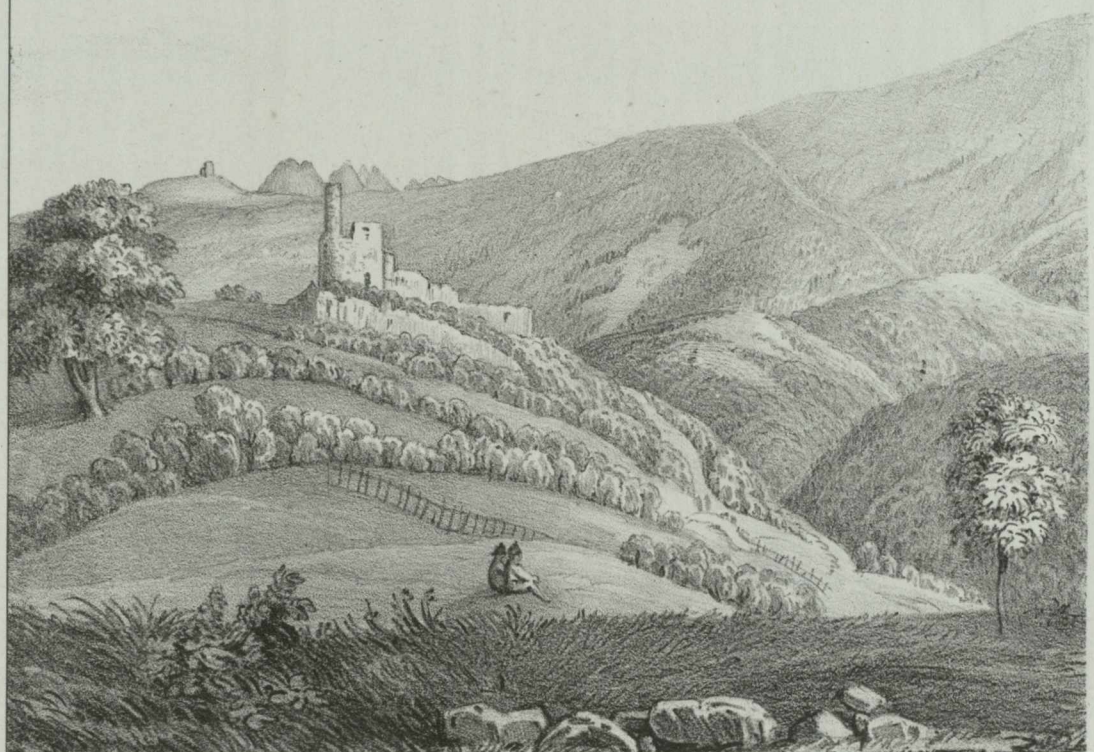
RUINE DU CHÂTEAU DE KHOTÉVI (Bas-Ratcha)
