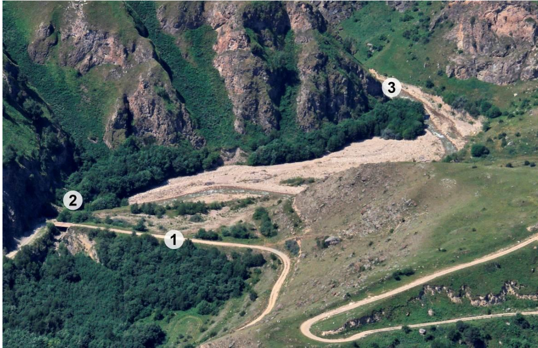
Рис. 3. Отложения селевых масс 2002 и 2014 гг. в верхнем бьефе тоннеля 2. Обозначения: 1 - подпорная плотина; 2 - входной портал; 3 - русло р. Гижгит. Вертолетный снимок М.Д. Докукина 15.07.2016 г.
