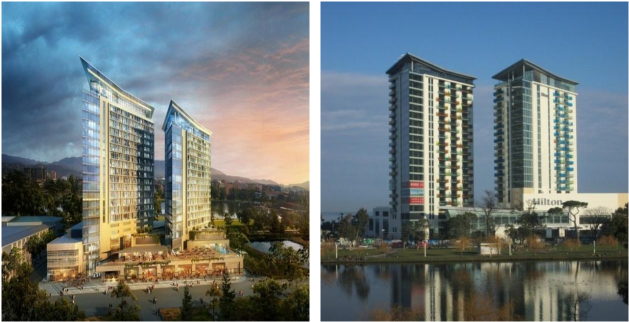
Фото 8,9. Вид гостиничного комплекса «HILTON» в г. Батуми со стороны моря (рендер) стороны озера «Нури» на период начала февраля 2015 г.
