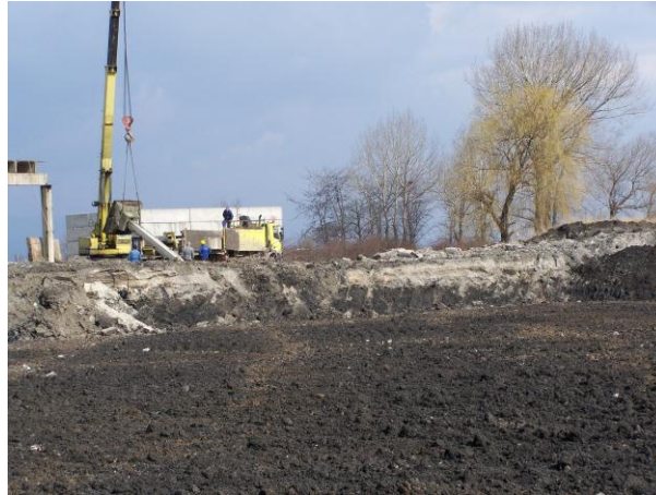
Подготовка площадки на „ex situ”
