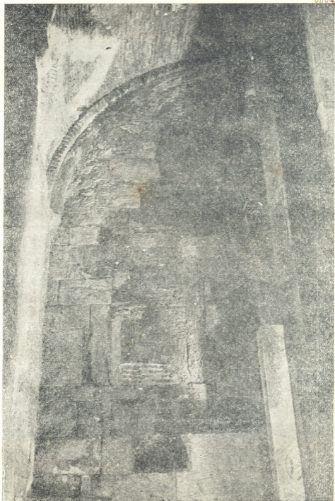
Рис. 12. Восточная стена с кирпичной закладкой в северном нефе.
