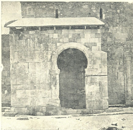
Рис. 45. Уцелевшая часть северной галлерей после раскрытого в 1939 г. северного проема.
