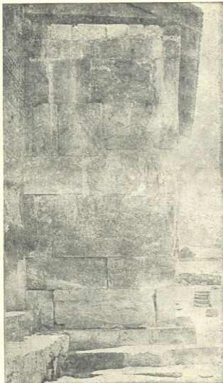
Рис. 26. Вид с востока на угол северной галлерей с показом отклонения северной стены.
