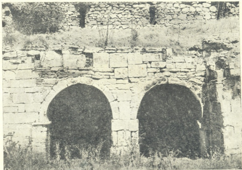
Рис. 40. Двойная арка входа (по фото 1916 года).
