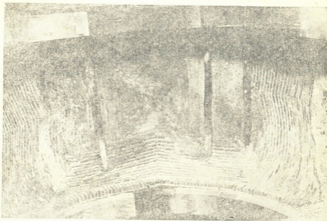
Рис. 84. Отрезок кирпичного свода XVII века в главном нефе базилики.
