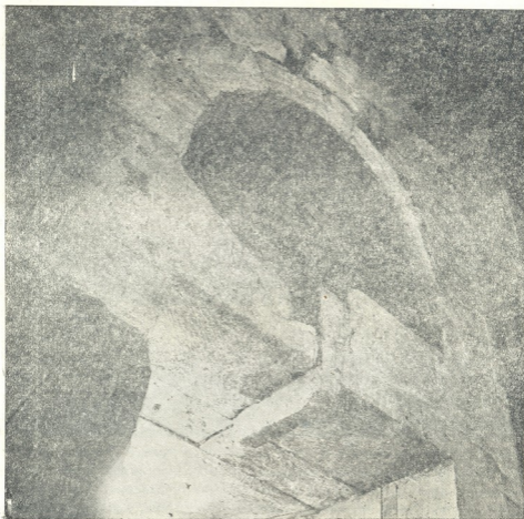
Рис. 13. Сквозной люнет и перемычка второй северной двери, изнутри, после раскрытия от закладки.
