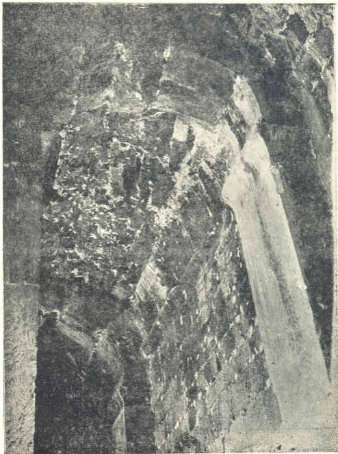
Рис. 17. Свод южного портика с выступающей карнизом пятой.
