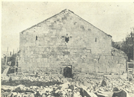
Рис. 35. Общий вид западного фасада при приступе к ремонту 1937 года.
