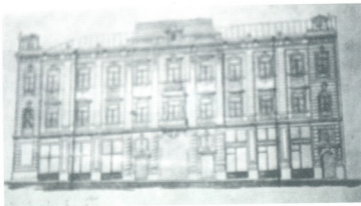
კონსტანტინე ზუბალაშვილის სახლი სასახლის ქუჩაზე (დღ. თავისუფლების მოედანი, ყოფილი ცეკაეშვირის შენობის ადგილზე). ფასადი. არქ. ზალცმანი. ფოტო 1880 წლისა
