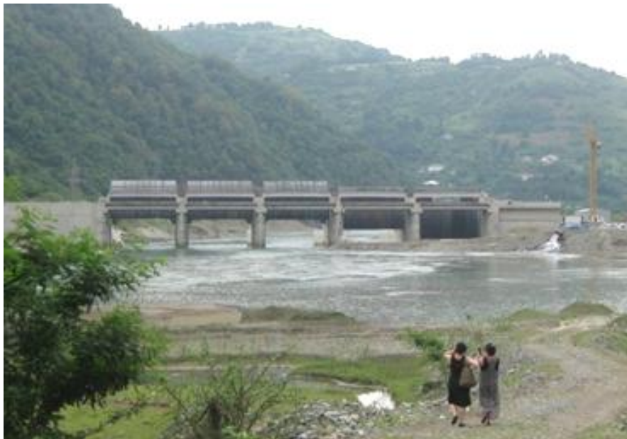
ნახ. 1.27. მდ. ჭოროხზე, სოფელ ერგესთან მშენებარე ჰესი (2015წ.)
