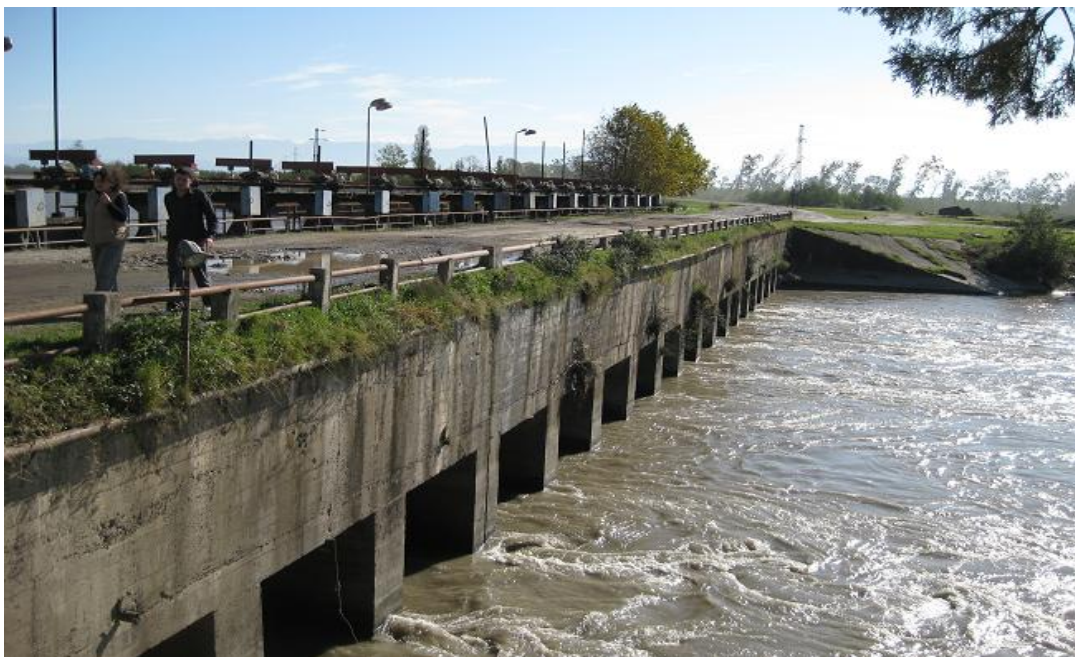
ნახ. 3.4. წყალგამყოფი ჰიდროკვანძის რაბ-რეგულატორის ხედი ქვედა ბიეფიდან
