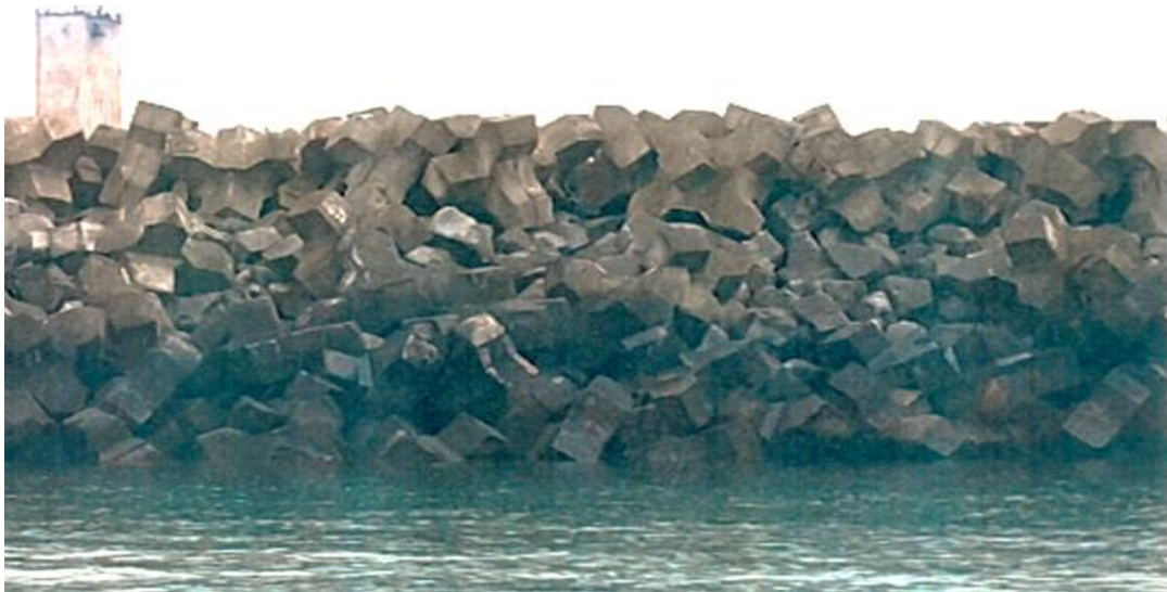
ნახ. 1.16. X-ბლოკებით 2008-2009 წლებში რეაბილიტირებული ფოთის პორტის დამცავი ზღუდარის რღვევის სურათი გარე აკვატორიის მხრიდან (2016 წელი)
