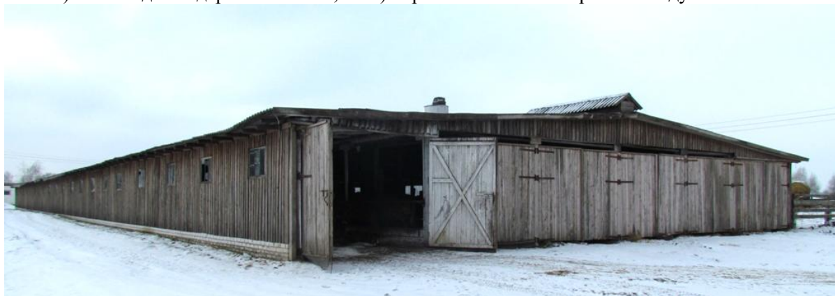
Рис. 2. Помещение из облегчённых конструкций (необрезная доска, деревянные столбы, стропила и лаги, шифер, бетонные опоры) для содержания маточного поголовья на глубокой подстилке (ОАО «Туровщина»).
