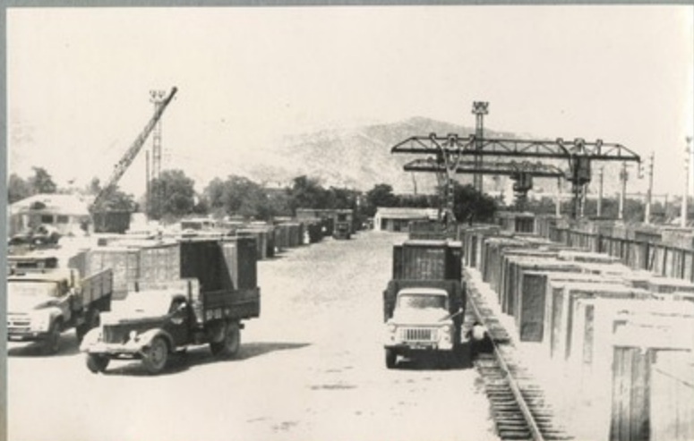
Контейнерная площадка на ст. Тбилиси-вр
