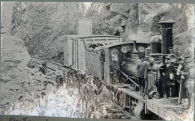
Рабочий поезд при ремонте пути
