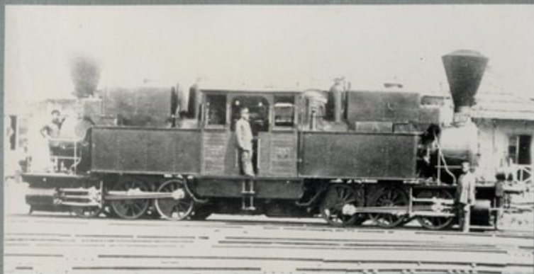
Фиг. 113. Товарный паровоз с машиной компаунд, построенный Коломыйским заводом в 1892 г.
