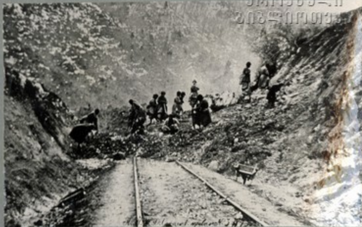
Огистка обвала на перевале
