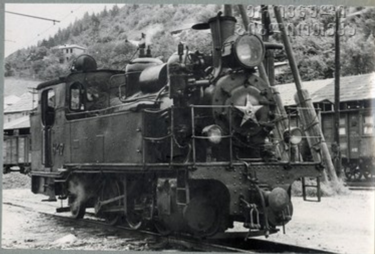
Узкоколейный паровоз серии ББ на нефтяном отоплении. Построен Коломенским заводом 1904г.
