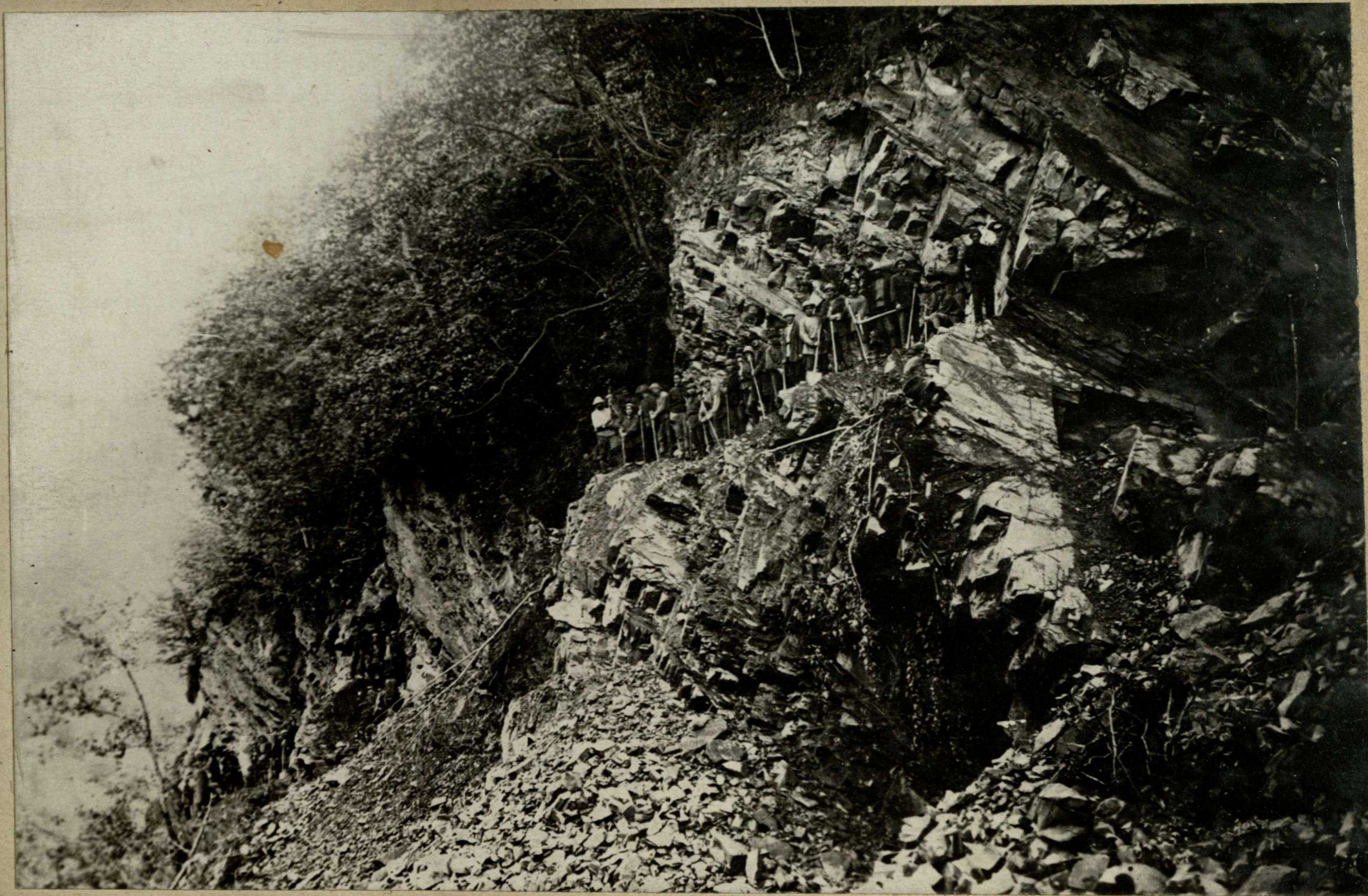
Ниже - Сванетская дорога. Разработка Ивдришских скал с трудучастьем. от пк №11+60 до пк №13.
