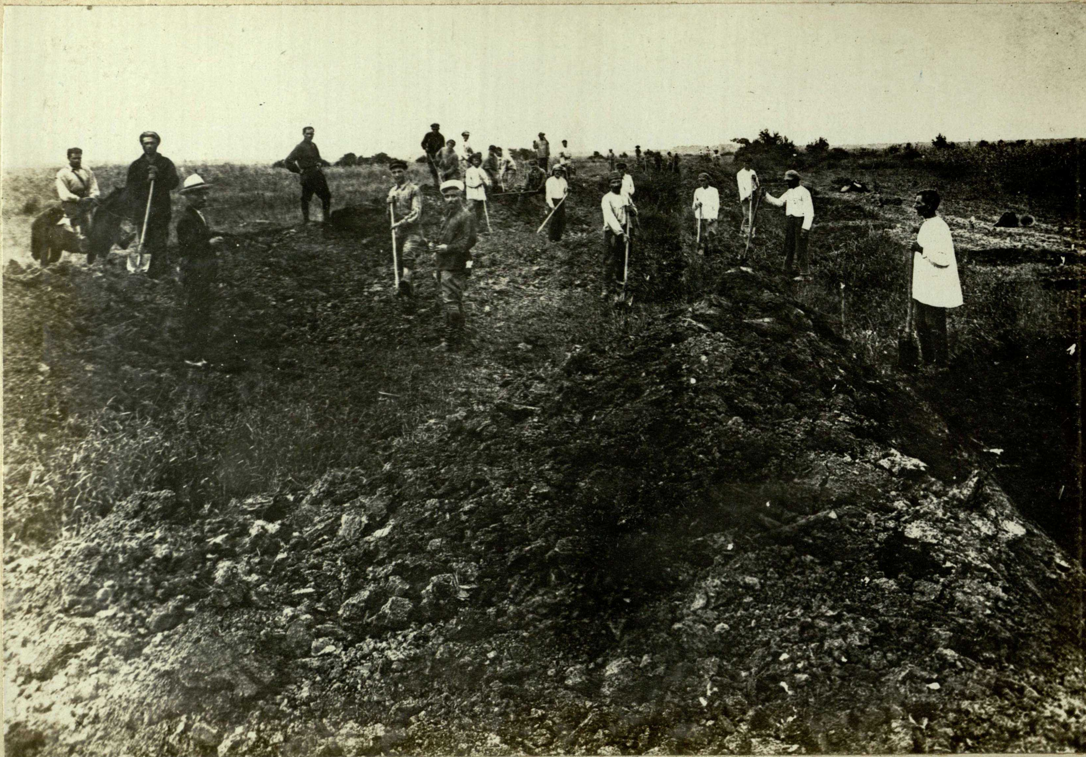
Земляные работы по возведению полотна дороги Сулса-Поти.
