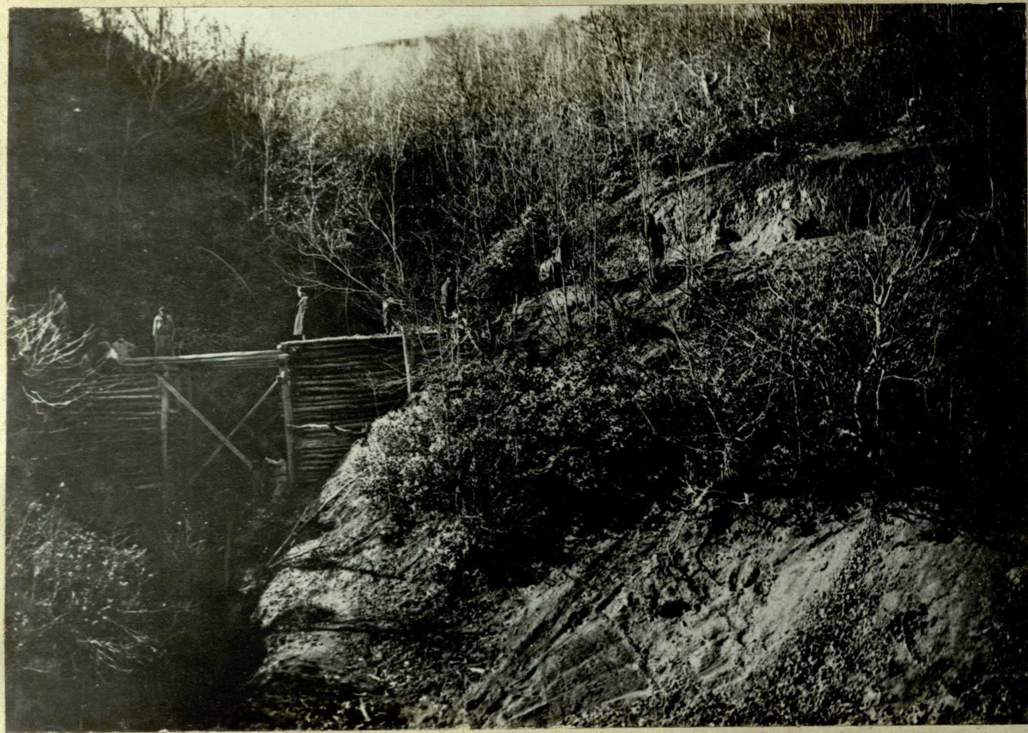
Сурам-Зестафонский перевал Постройка второго временного моста на 3 ем серпентине
