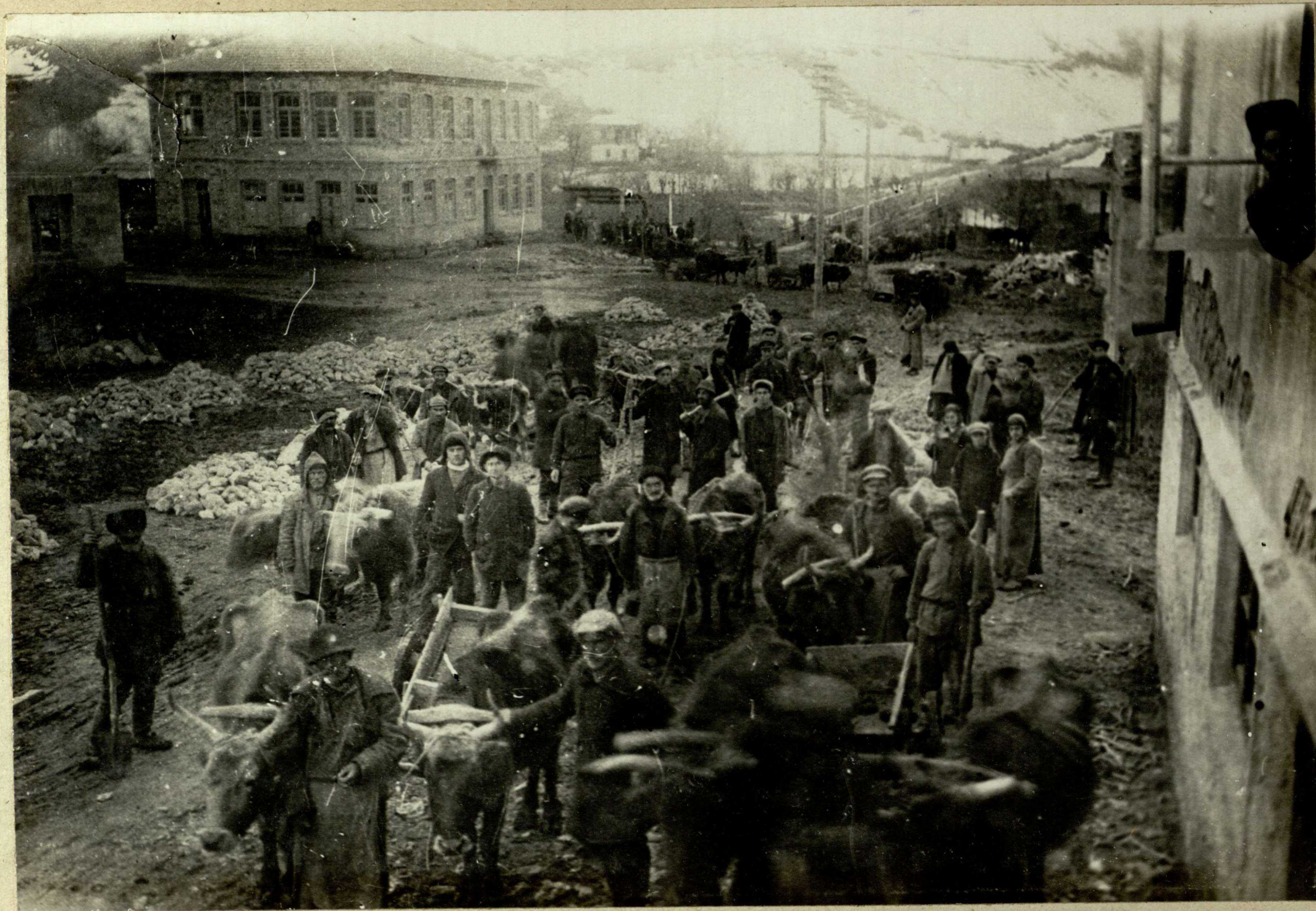
Капитальный ремонт дороги в самом Амбролауре - Подвозка камня.
