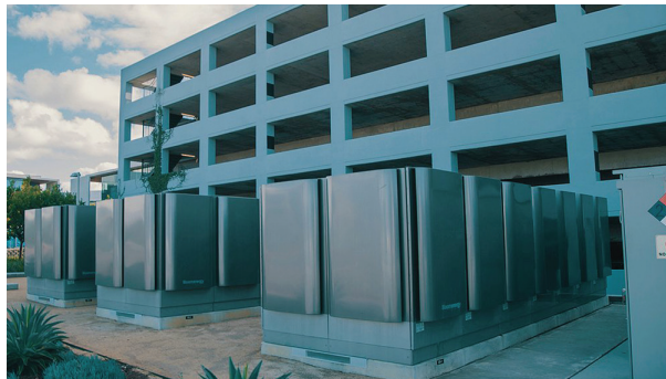
ენერჯომომარაგებულო Bloom-ის ეს დანადგარები სან-დიეგოს La Jolla Commons-ში, წელიწადში, დაახლოებით 5 მილიონ კილოვატსაბათ ელექტროენერჯიას აწარმოებს.
