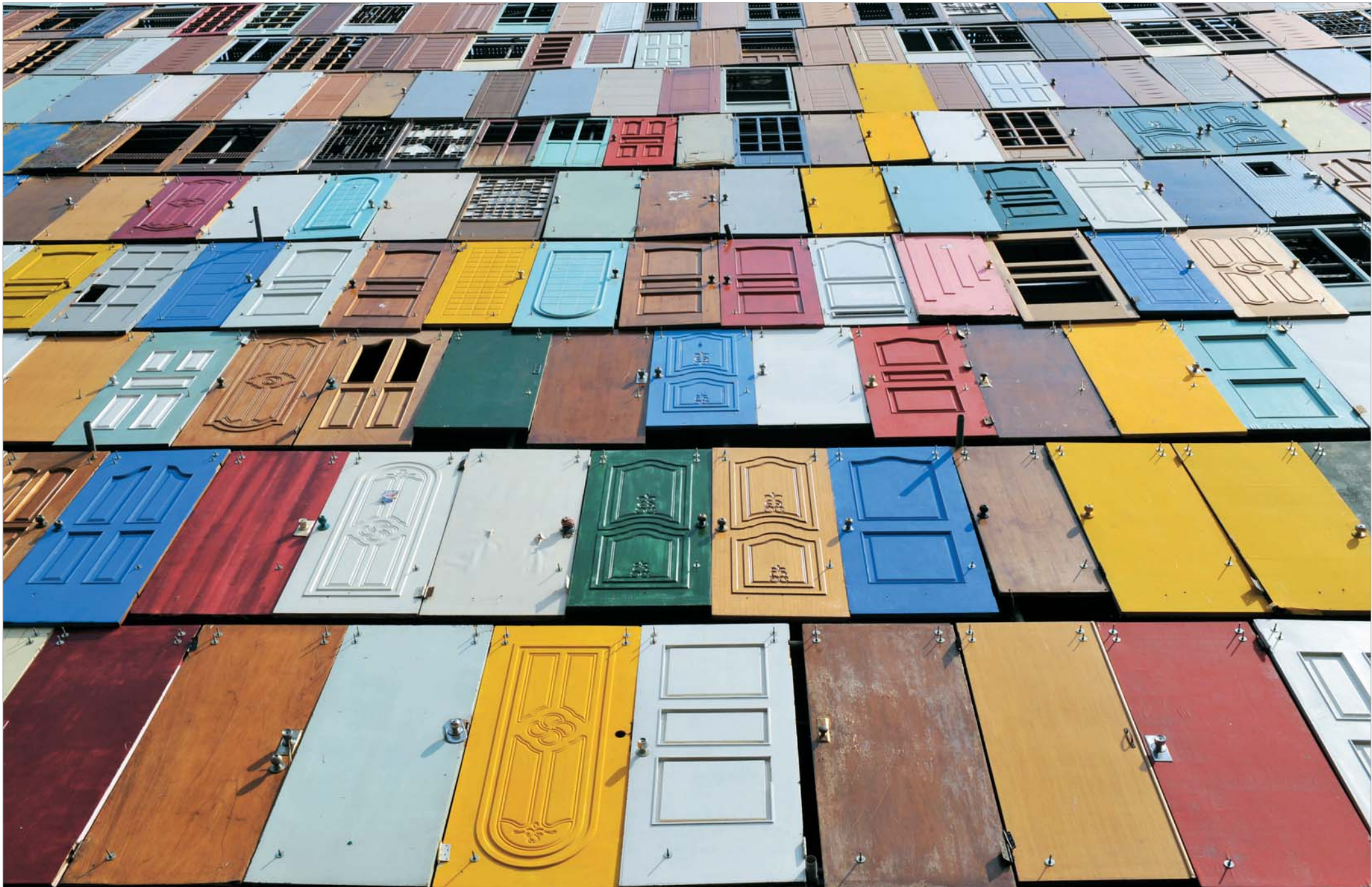
კორეის დედაქალაქ სეულში უჩვეულო შენობა აღმართეს. მისი კედლები სხვადასხვა ფერისა და ფორმის კარებებითაა მოპირკეთებული. შენობა პრაქტიკულად ხელოვნების ნიმუშს წარმოადგენს და მის სანახავად უამრავი ადამიანი იკრიბება. აღსანიშნავია ისიც, რომ ყველა ეს კარი ადრე სეულის მაცხოვრებლებს ეკუთვნოდათ და როდესაც ამ შენობის მოპირკეთების შესახებ გახდა ცნობილი, საკუთარი სურვილით მიიტანეს პროექტის ავტორებთან.
