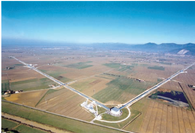
სურ. 62 ფრანგულ-იტალიური ინტერფერომეტრი VIRGO (მზრის სიგრძე – 3 კმ). მას შეუძლია 1000 კმ-მდე სიგრძის მქონე გრავიტაციული ტალღის რეგისტრაცია © CNRS/IN2P3
