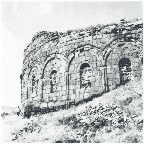
Bana. Mur extérieure.
