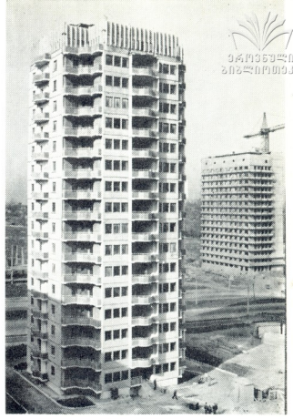
16 სართლიანი 64 ბინიანი საცხოვრებელი სახლი მუხიანში. საერთო ხედი. არქ. ე. კვიციანი. ინჟინრები: ა. კიმბერგი, ა. ჩიქობავა, გ. თურმანიძე, ბ. ბარბაქაძე, ნ. კახანიძე, მ. ბედიასვილი, დ. ჯობაძე, ნ. გრიგოლია
