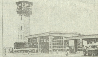
საბუტოლისტების აზრით, სარფში ავგებული საკონტროლო-გასაბეჭდო კომპლექსისა და ბაბუშული არქიტექტორების მიერ შექმნილი შიტი უსაკალური საოცრებად კომპლექსის ბადალი არ არსებობს თანამგობობის ქვეყნაში.
