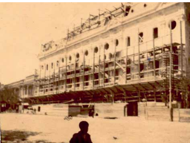
▲ Строительство здания АРТО
