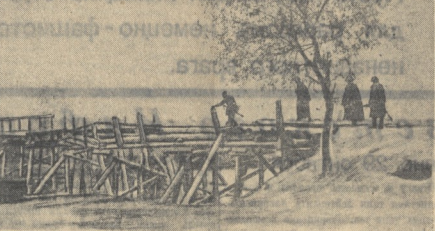
Действующая Армия. На снимке: разведка моста саперами перед восстановительными работами. Фото М. Реакна, (ТАСС).
