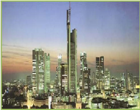
სურ 48. შენობის სამკუთხა დიზაინი შეიცავს ცენტრალურ ატრიუმს, რომელიც წარმოადგენს ბუნებრივ სავენტილაცია სისტემას.
