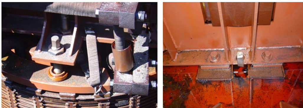
ნახ. 1. მყარი მინარევები ტრანსფორმატორის აქტიური ნაწილის ზედაპირზე
