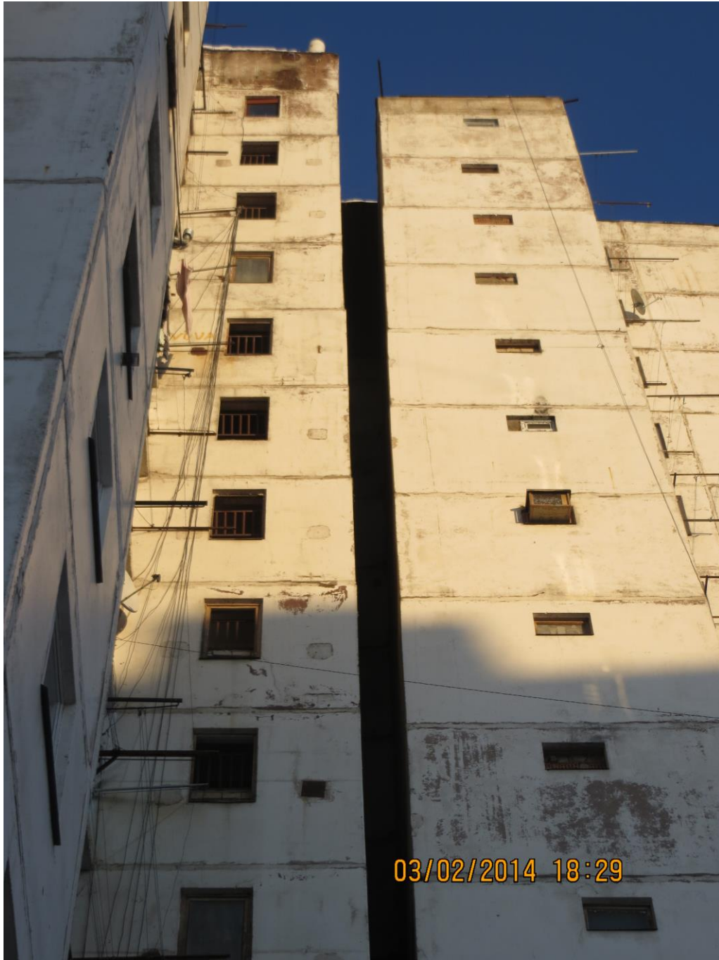
სურათი 4.2.2 საცხოვრებელი სახლის ხედი მთლიან სიმაღლეზე, გადახრა მიმდებარე სახლებთან თვალსაჩინოა.
