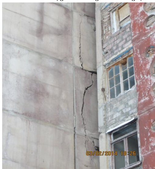
სურ. 4 იგივე საცხოვრებელი სახლის გვერდითი ხედი კედლის პანელებზე გამჭოლი ბზარებია.
