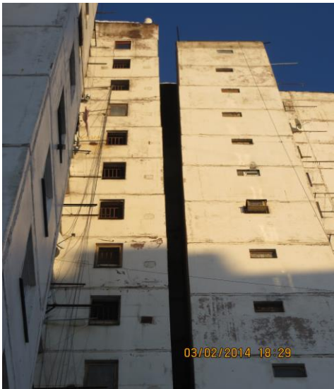
სურ. 3 საცხოვრებელი სახლის გადახრა მთლიან სიმაღლეზე, მიმდებარე სახლებთან შედარებით თვალსაჩინოა.
