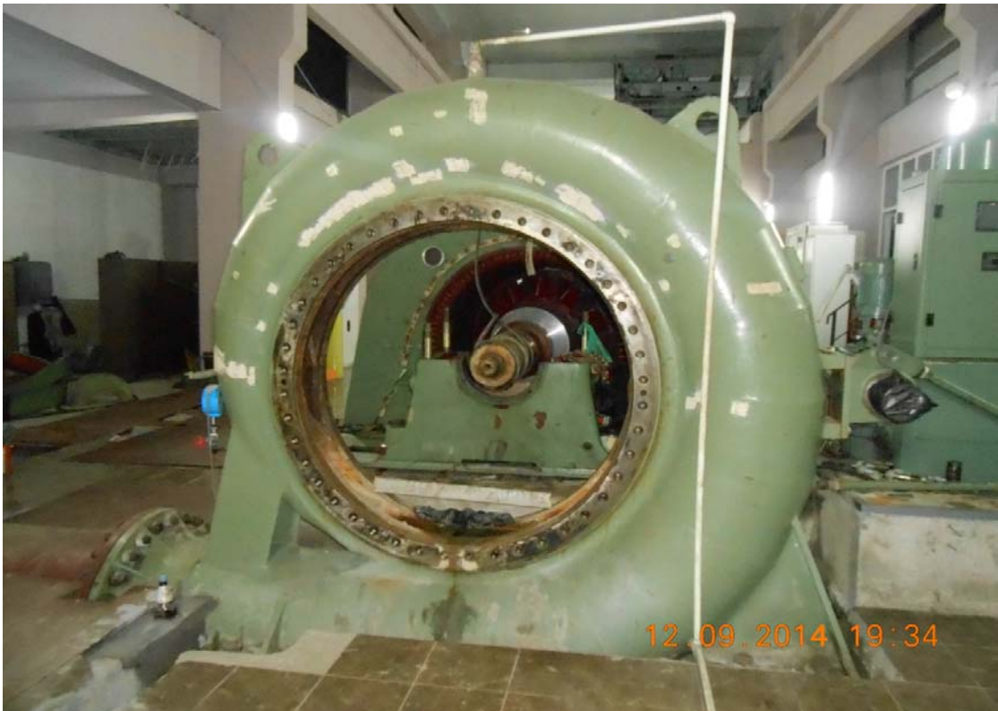
სურ. 2 ჰიდროაბრაზიული ცვეთით მწყობრიდან გამოყვანილი რაჭა ჰესის №2 ჰიდროტურბინა
