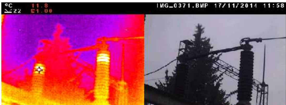
ნახ. №38 ქვესადგური „მარნეული-1“-ის 110კვ გამოთიშველის დეფექტური იზოლატორის თერმოგრაფია
