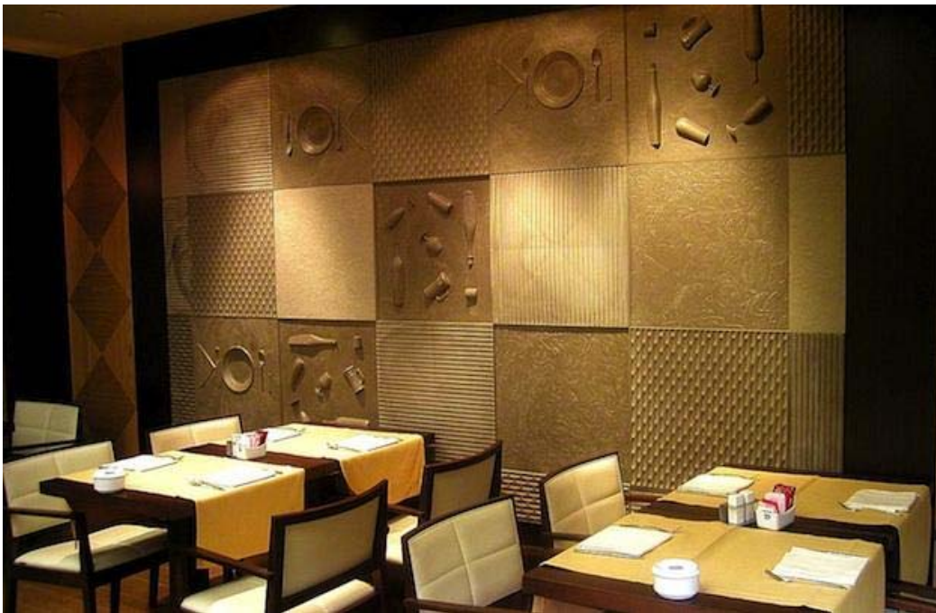
ნახ. 59. კედლის გამოყვანა 3D პანელებით მერქანბურბუშელოვანი ფილისაგან.
