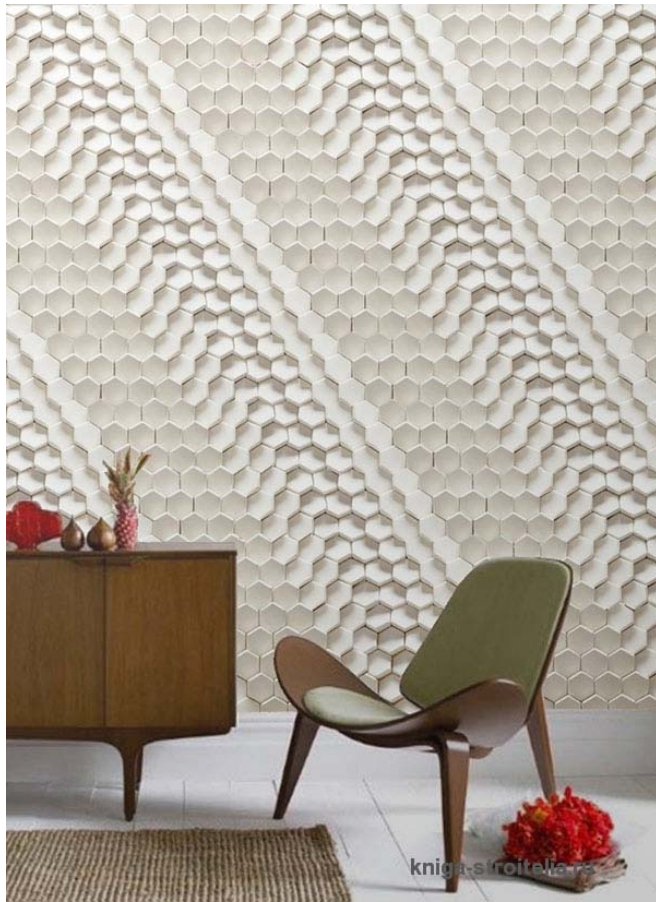
ნახ. 59. კედლის გამოყვანა 3D პანელებით მერქანბურბუშელოვანი ფილისაგან.
