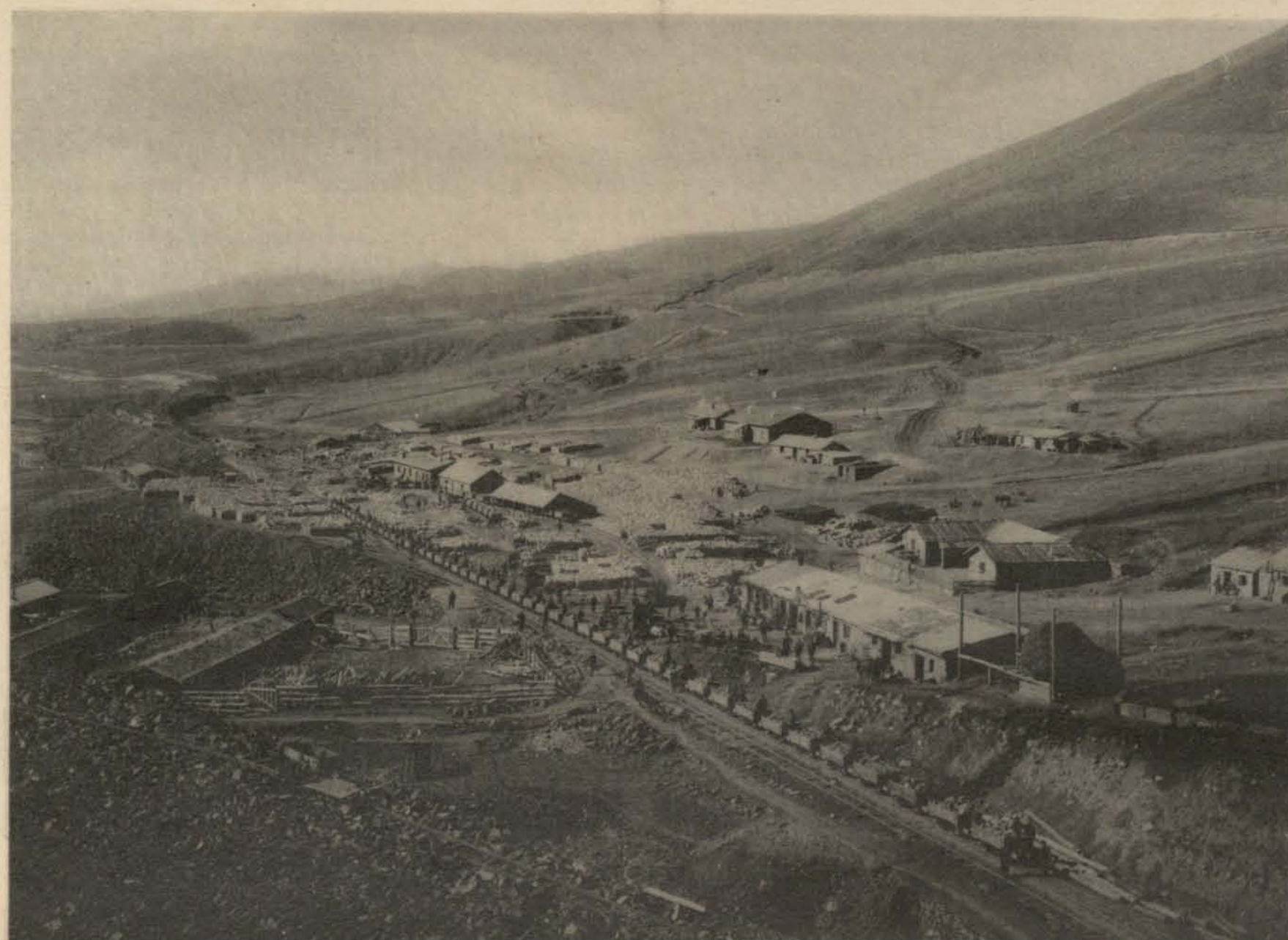
Рабочая станція съ восточной (Тифлисской) стороны.
