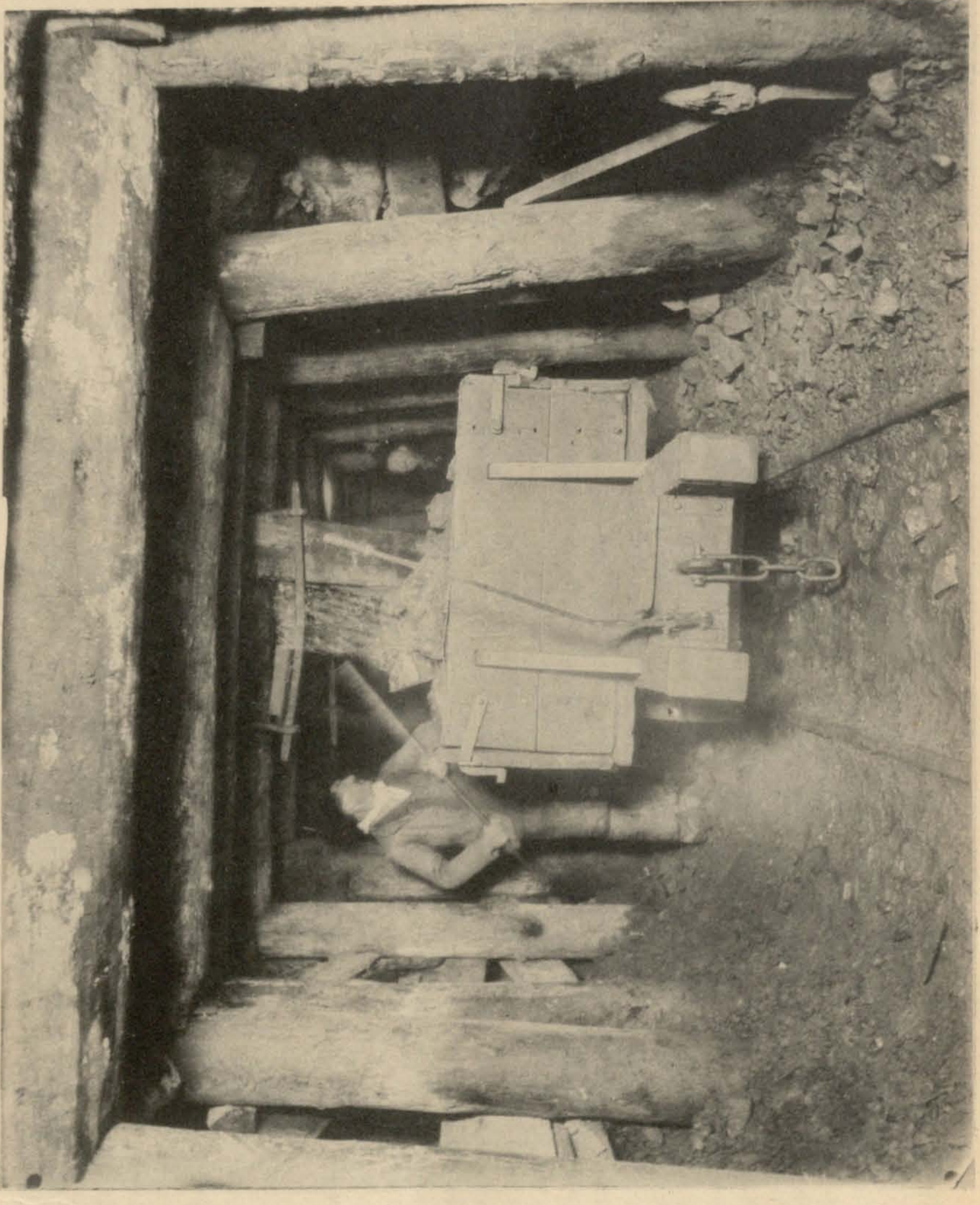
Нижній ходъ. Черезъ воронку рабочій вагончикъ нагружается породой изъ верхнихъ разработокъ.
