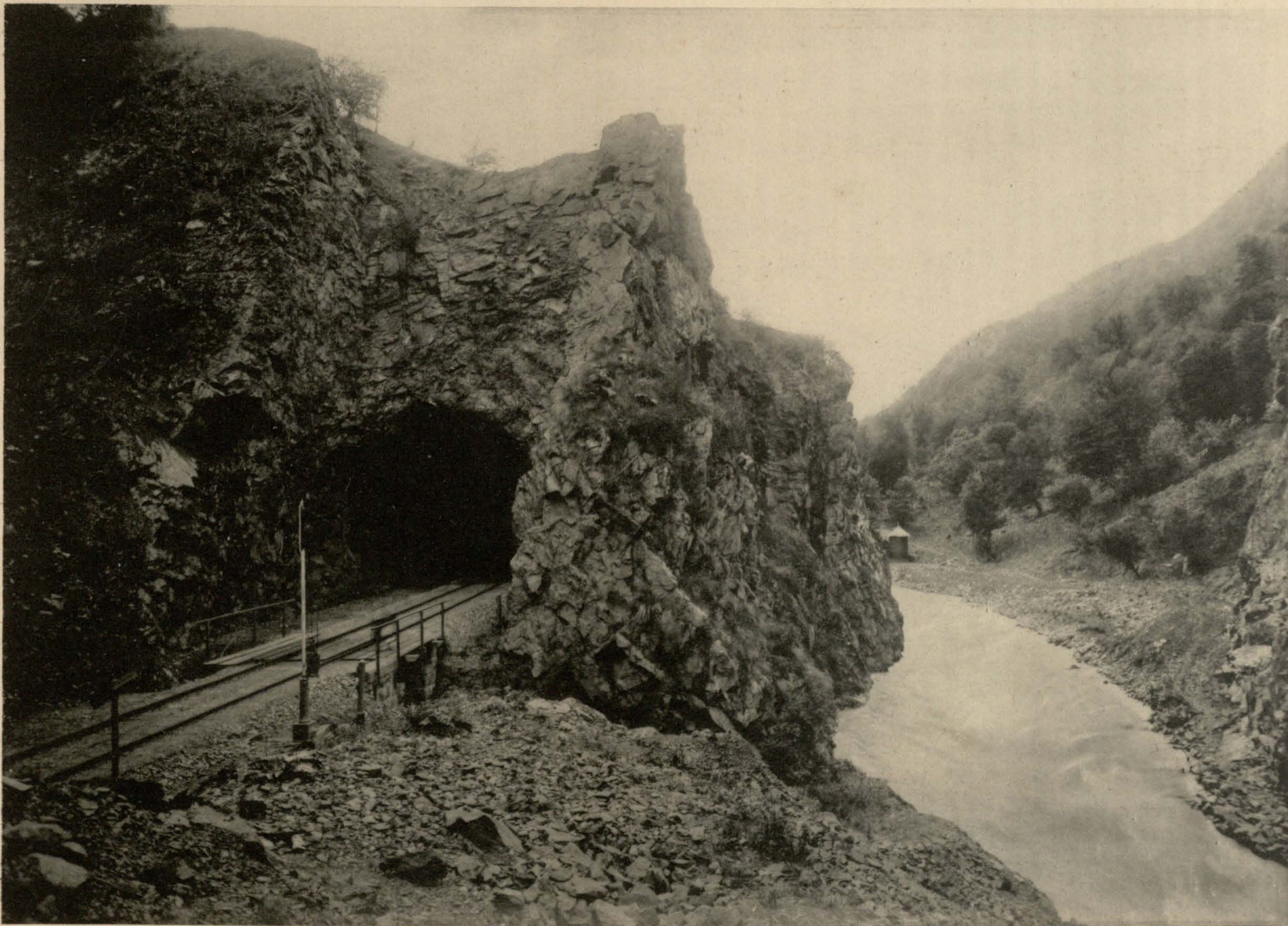
Порталъ того же тоннеля близъ входа на ст. Калагеранъ, вер. 119-ая.
