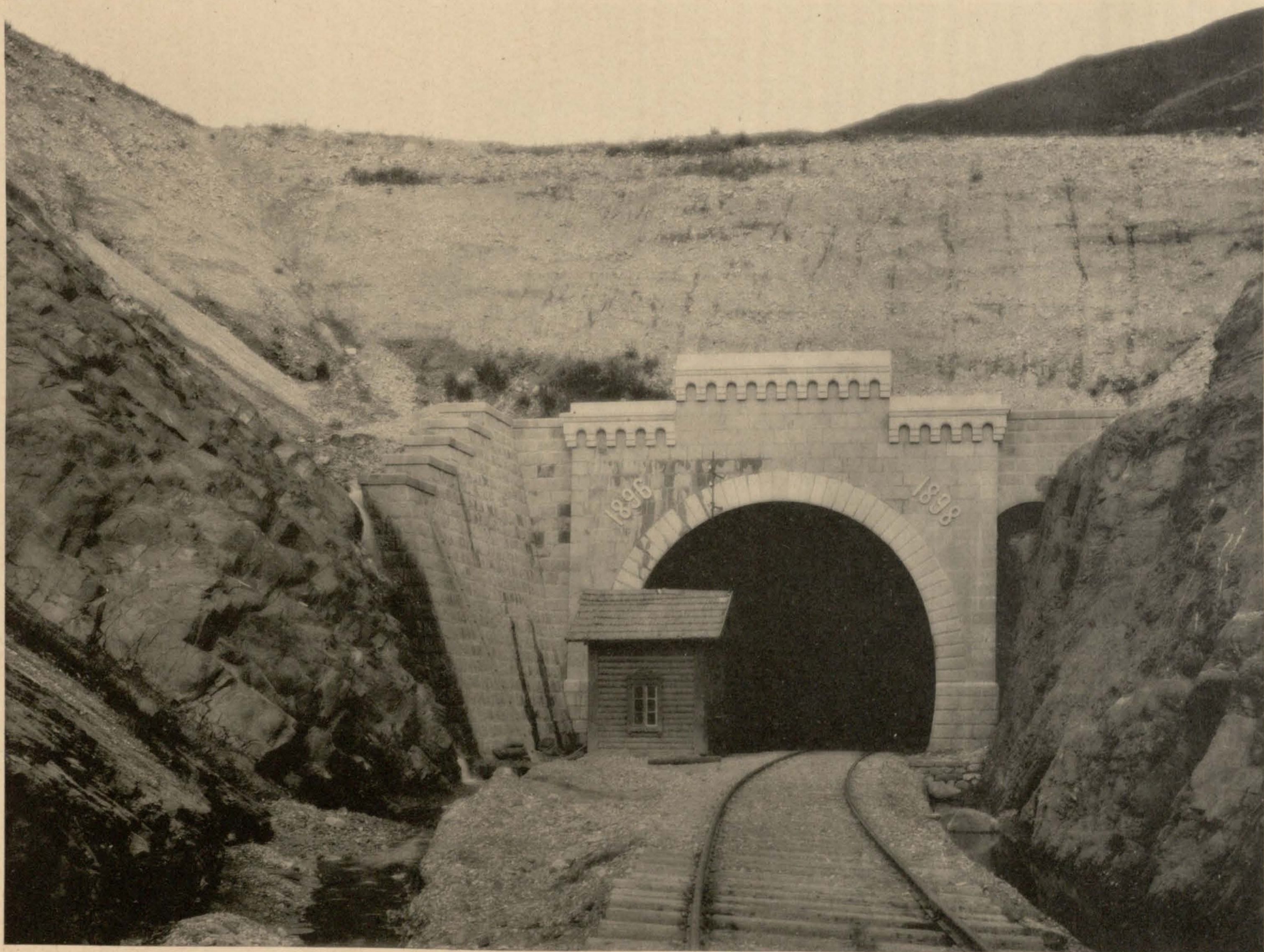
Порталь тоннеля съ западной стороны.
