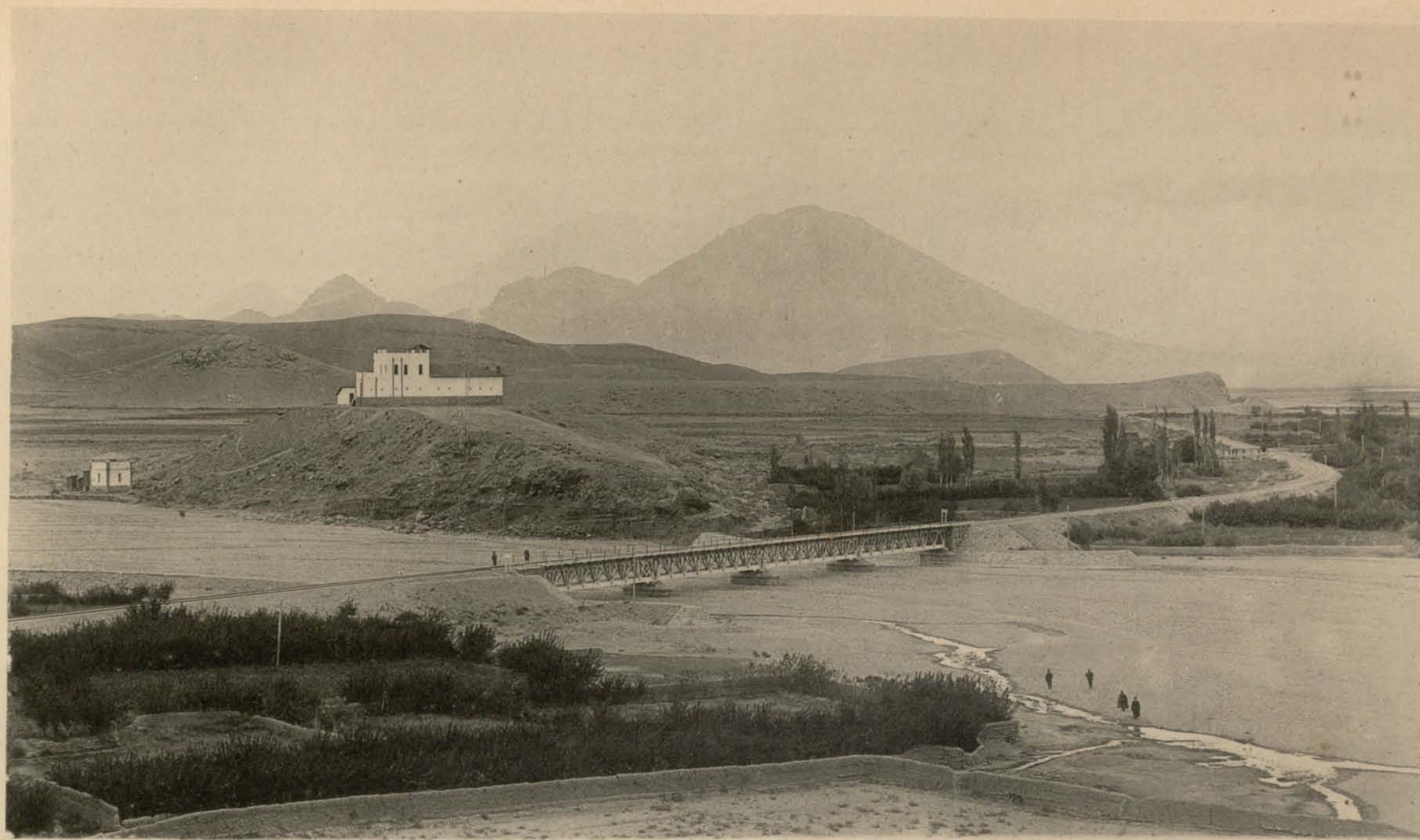
Видъ мѣстности у моста отв. 40 саж. черезъ рѣку Алинджа-най и блокгауза, вер. 512.
