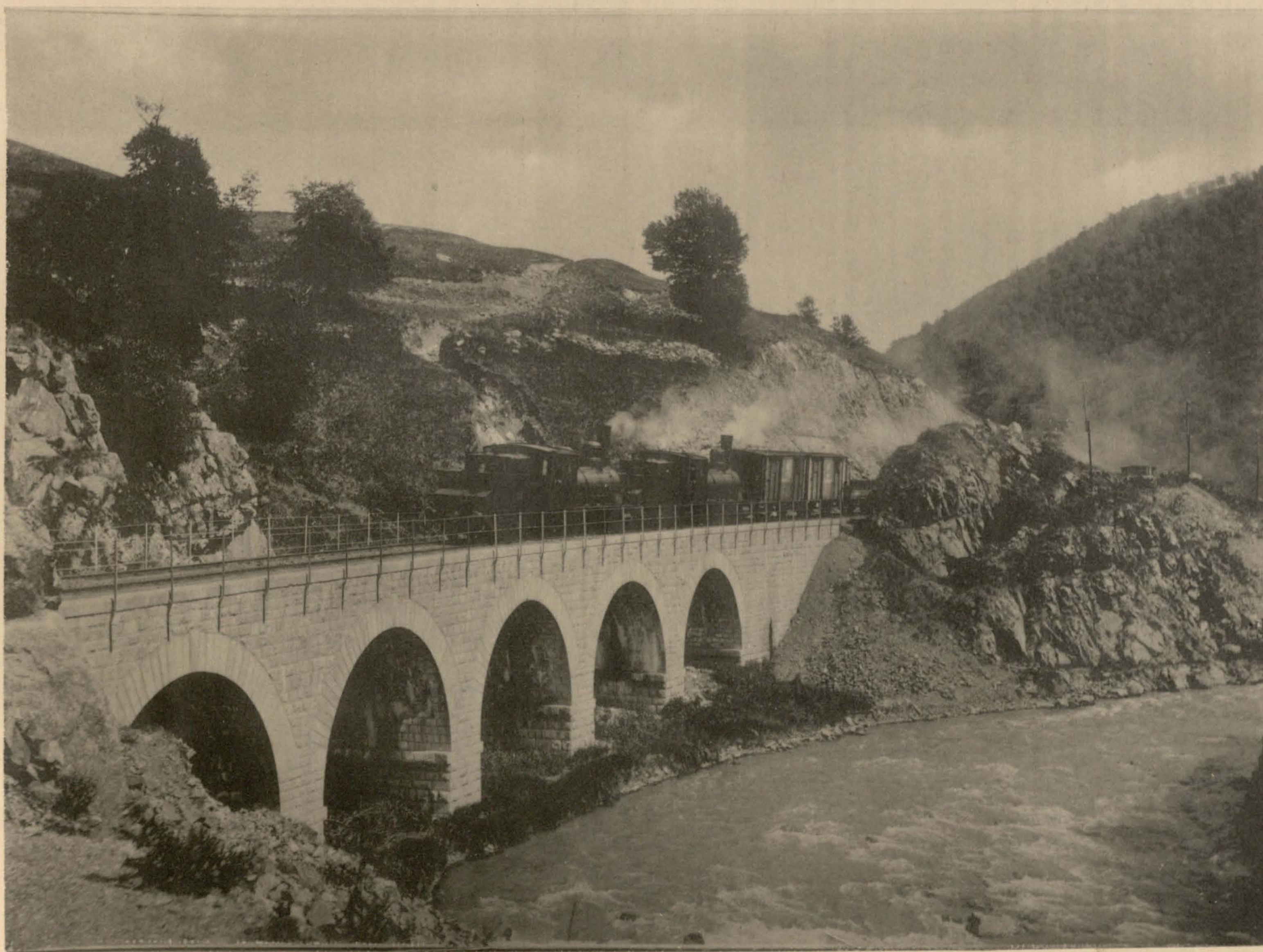
Віадукъ (5 пролетовъ по 4 саж.) на 134 верстѣ между двумя скальними выемками.
