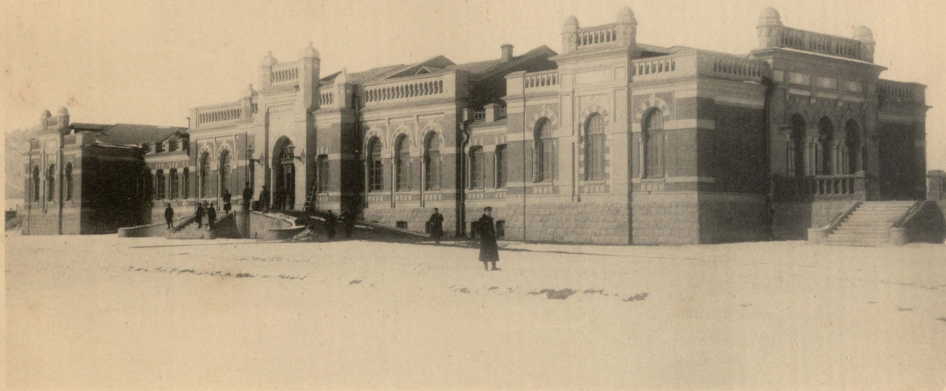
Пассажирское здание на ст. Джульфа, вер. 516.
