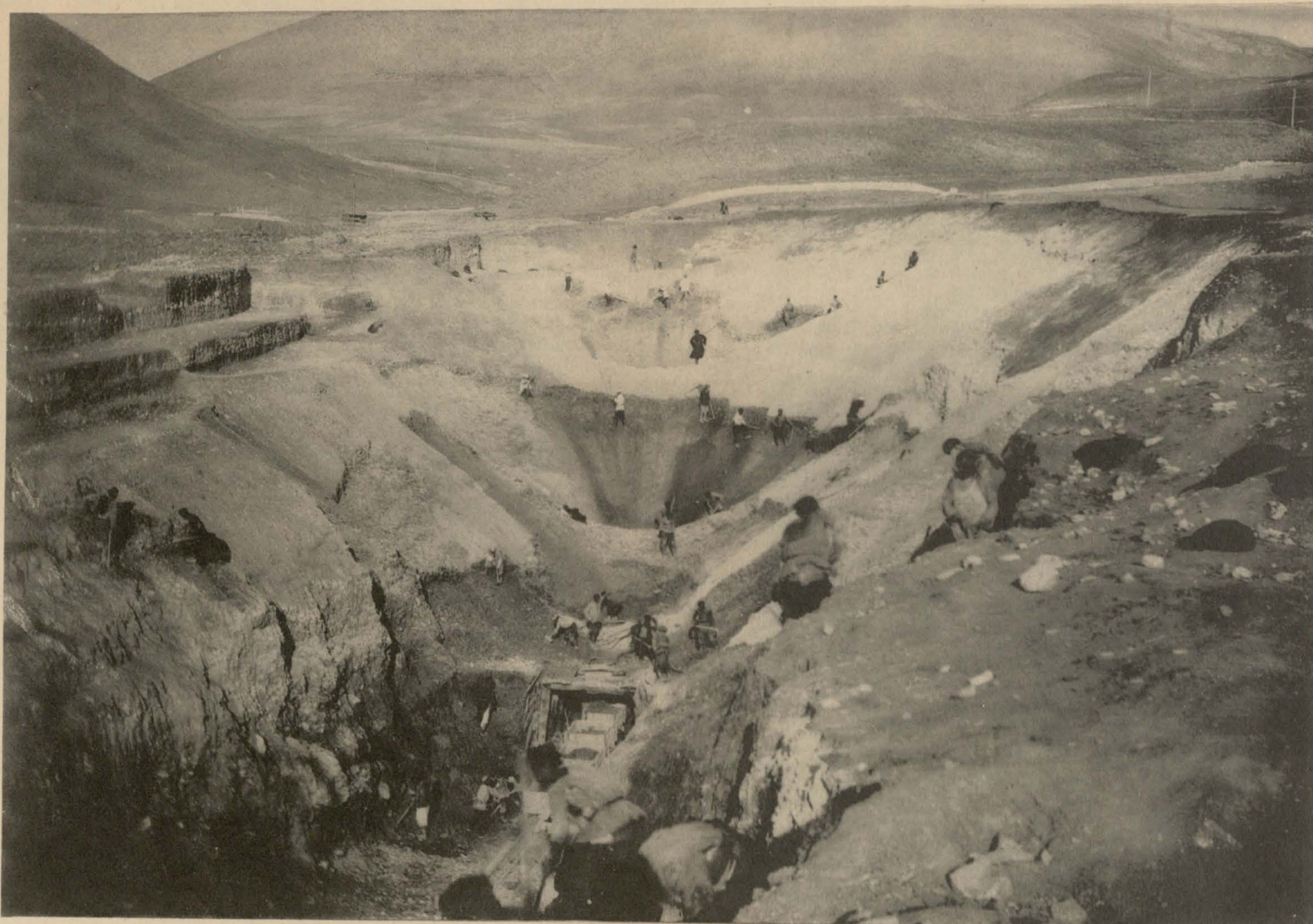
Разработка западной подходной выемки. (длиной 250 саж., наибольшей глубиной 11 саж.) англійскимъ способомъ.
