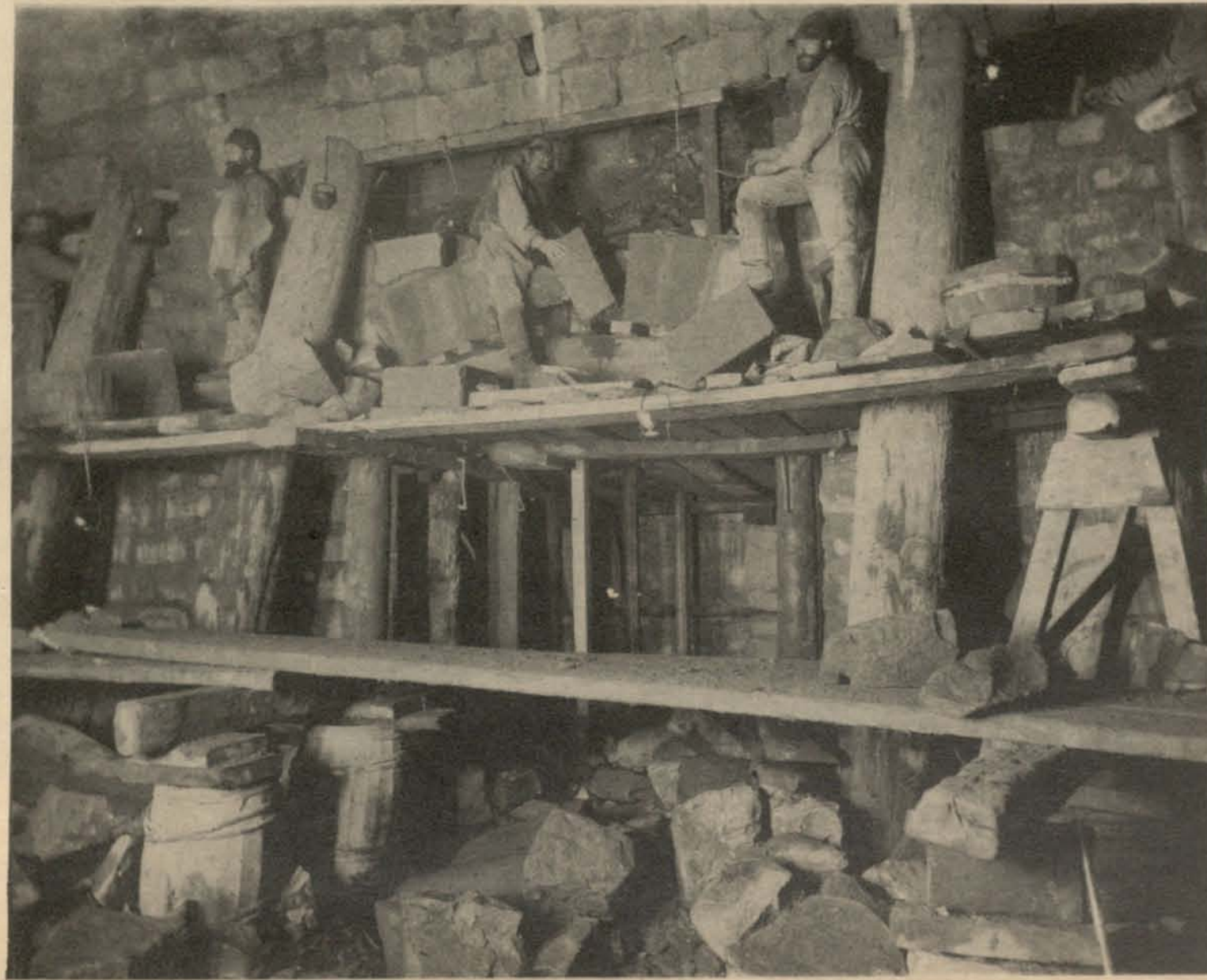
Устройство большой ниши въ серединѣ тоннеля.
