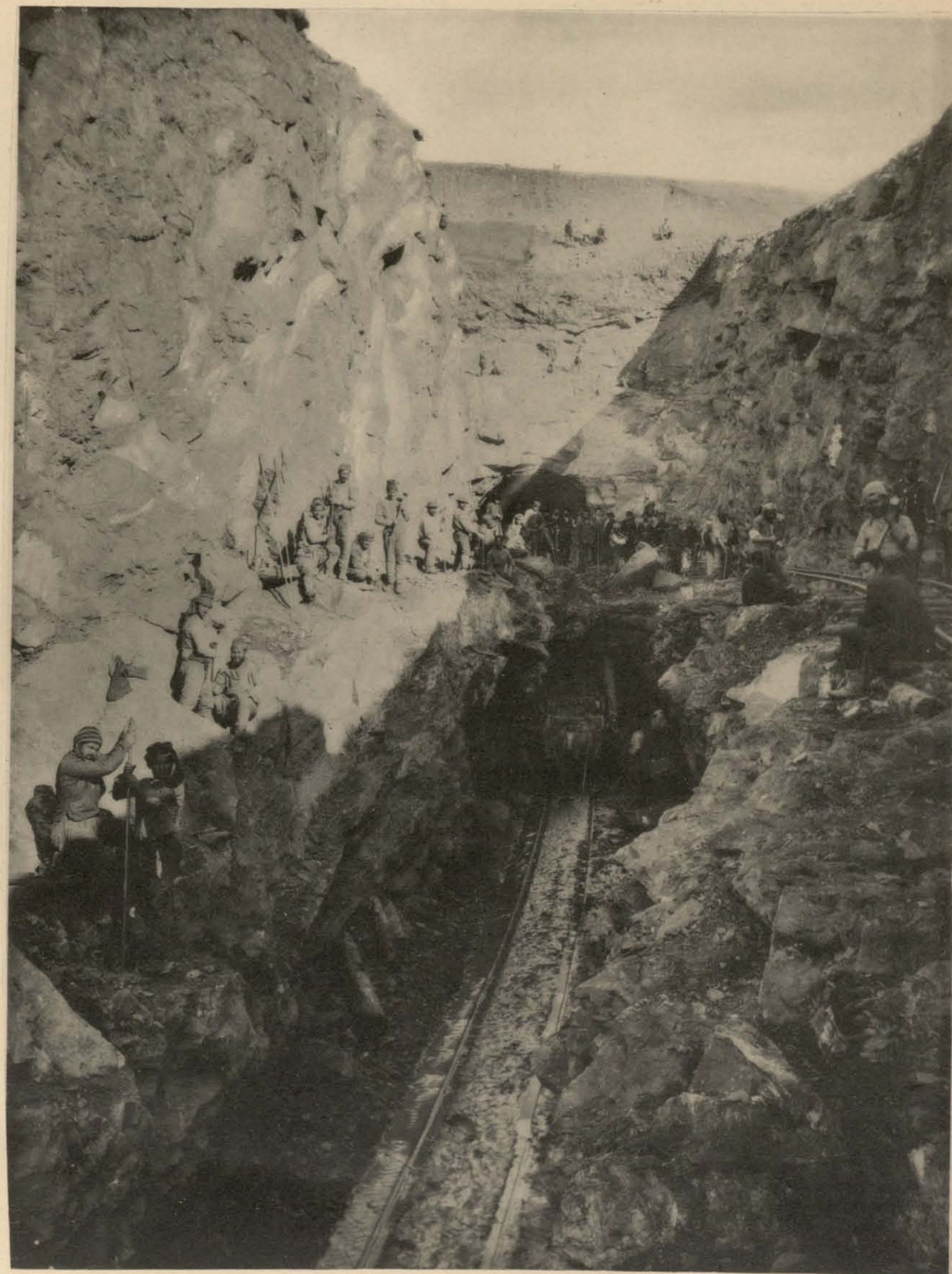
Разработка подходной выемки съ восточной стороны. (Видны верхній и нижній направляющіе ходы).
