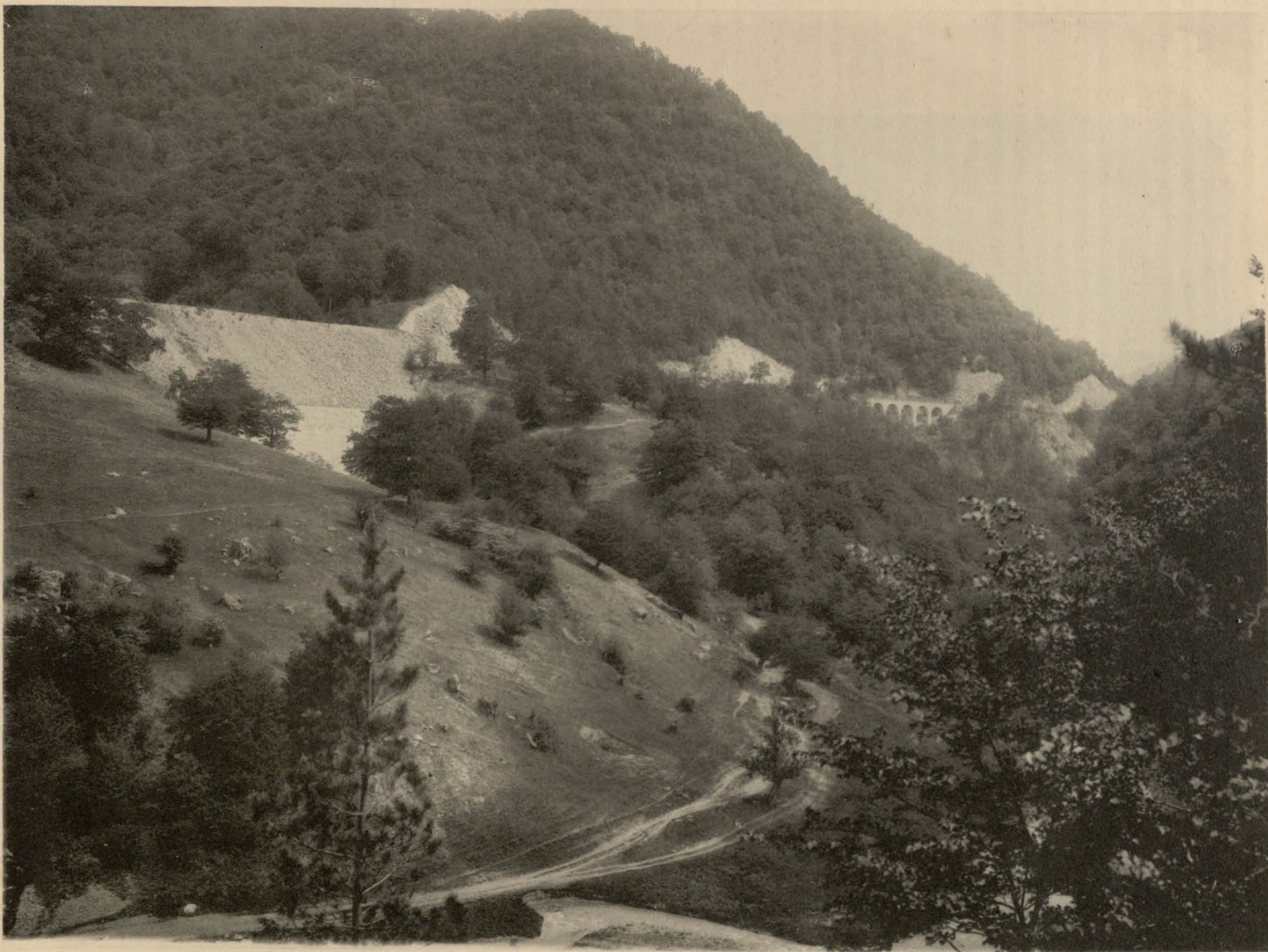
Общій видъ работъ 130—131 вер. Справа тотъ-же виадукъ. Слева каменная насыпь выс. 27 саж.
