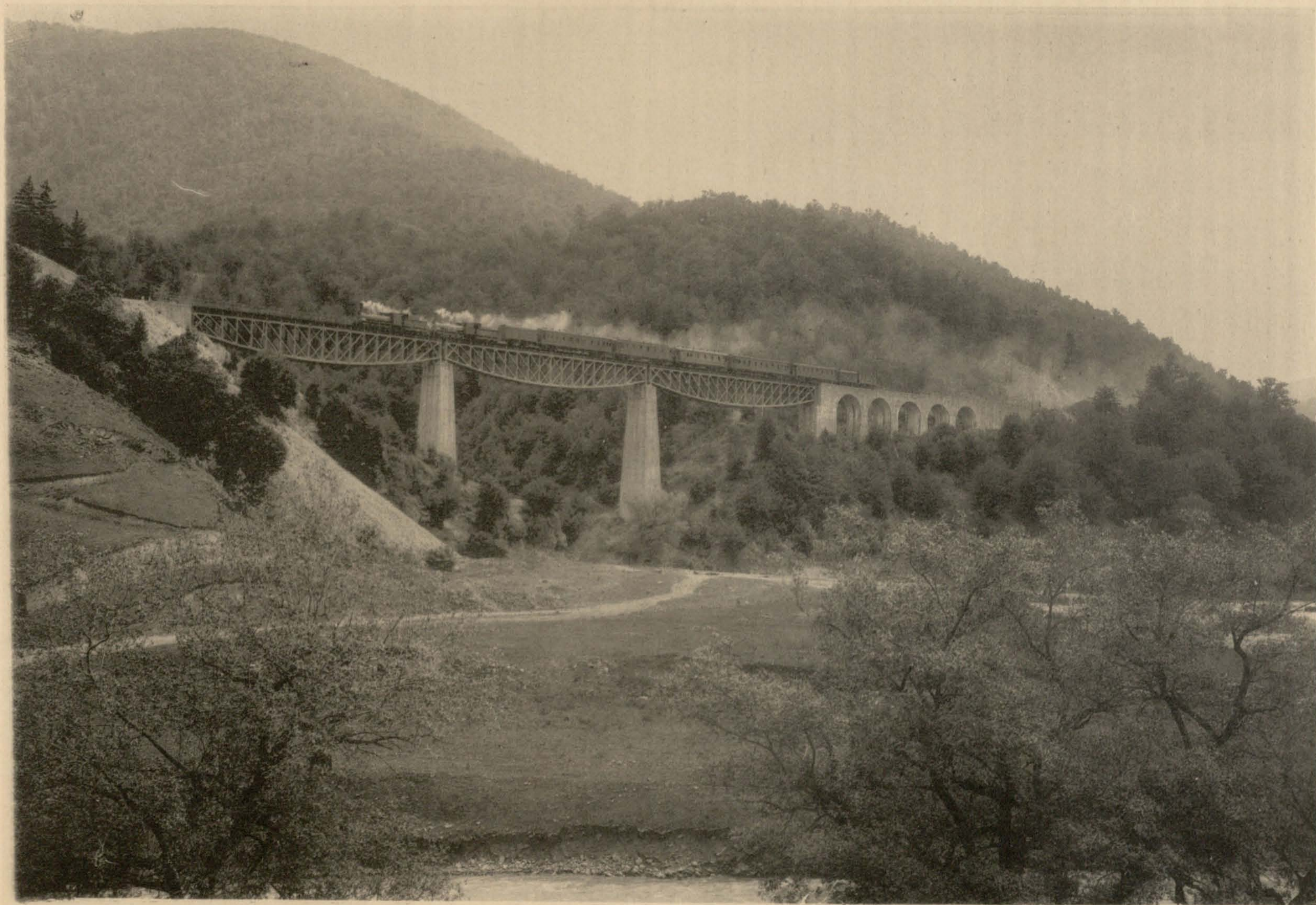
6) Сборка и склепка фермъ виадука закончена.
