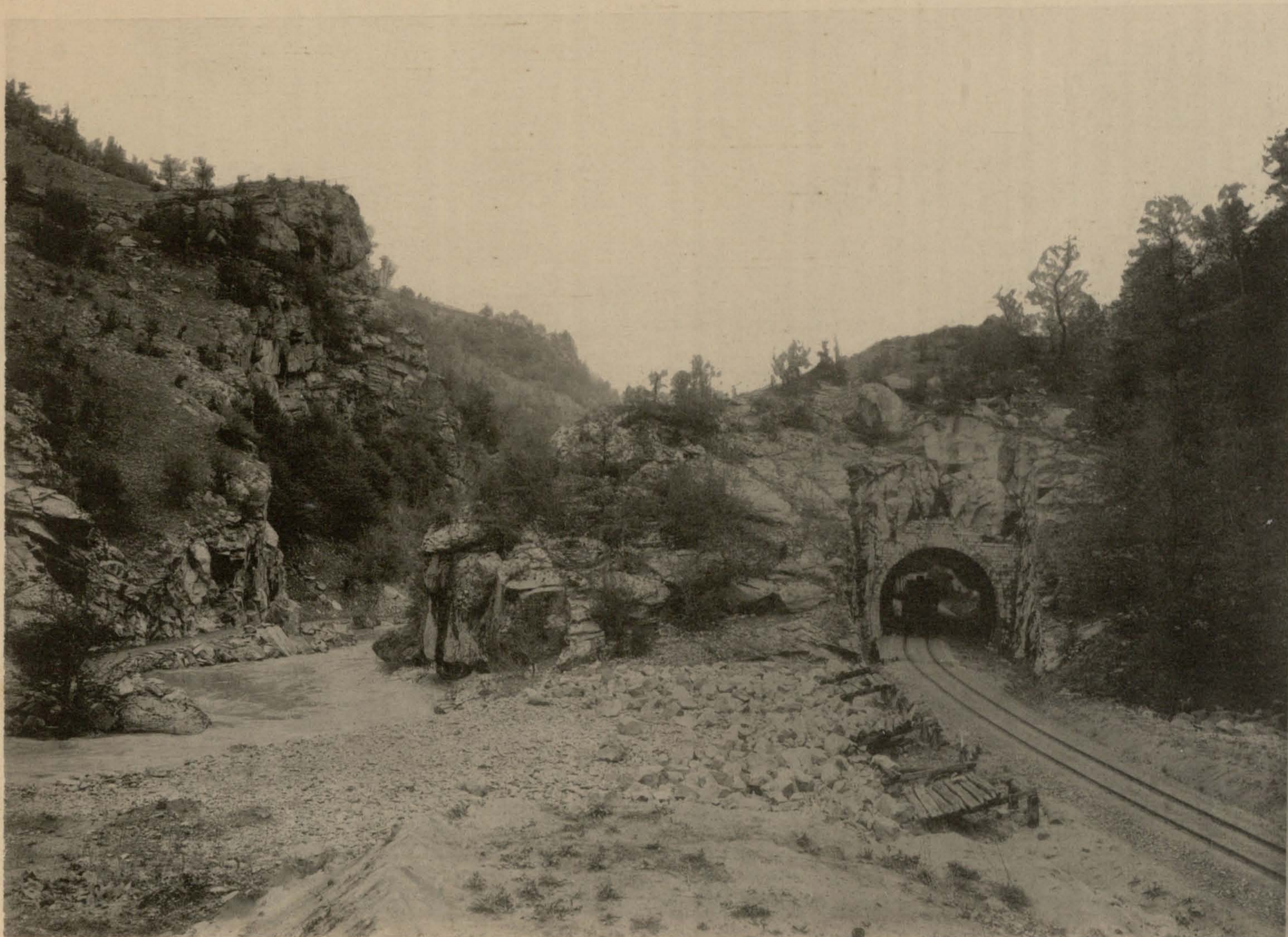
Тоннель въ вывѣтривающейсѣ скалѣ, потребовавшій облицовки, вер. 123.
