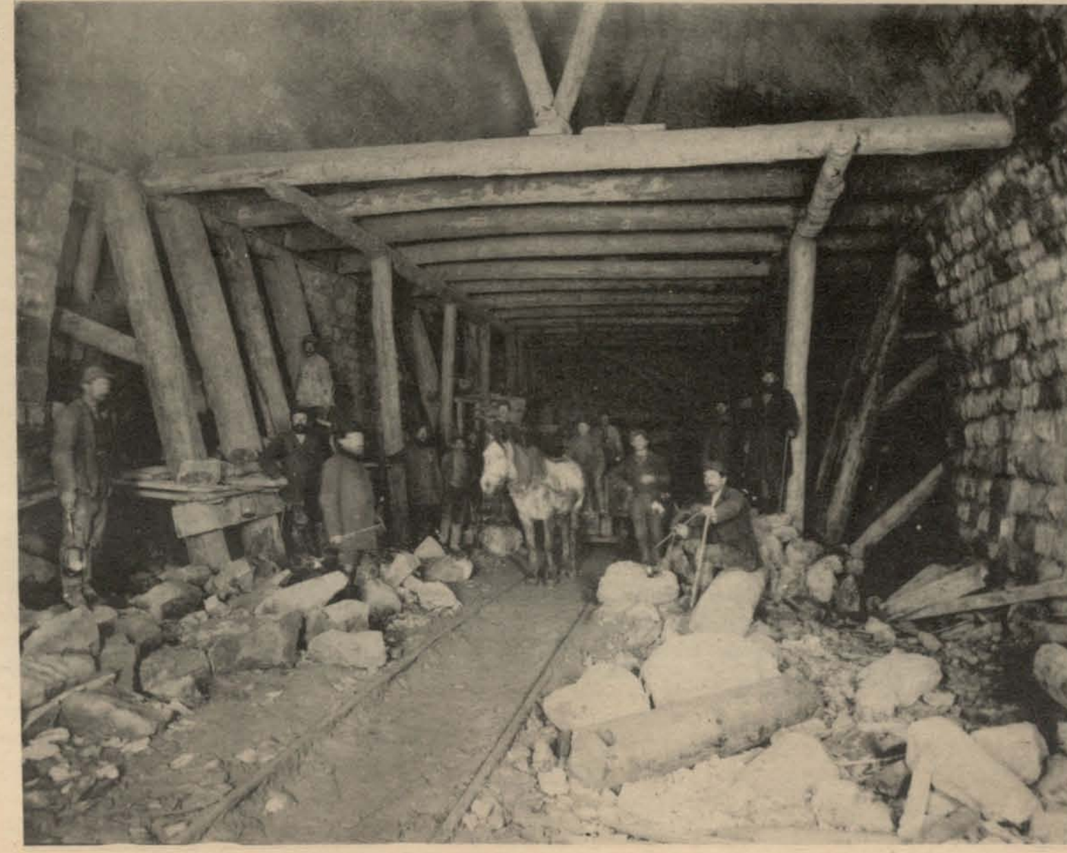
Общій видъ укрѣпленія свода и устройство стѣны.
