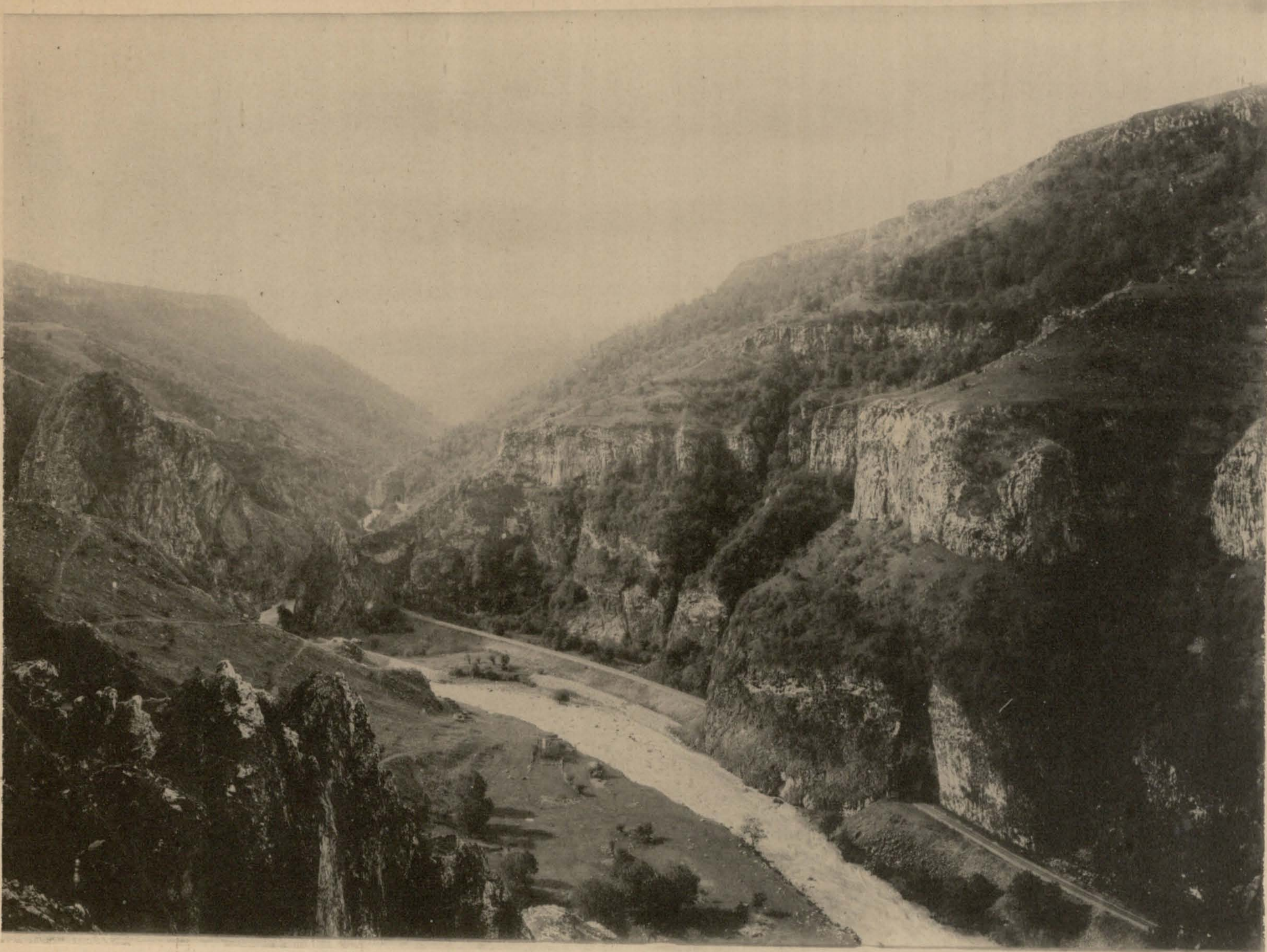
Общій видъ полотна и трехъ тоннелей, версты 118-119.
