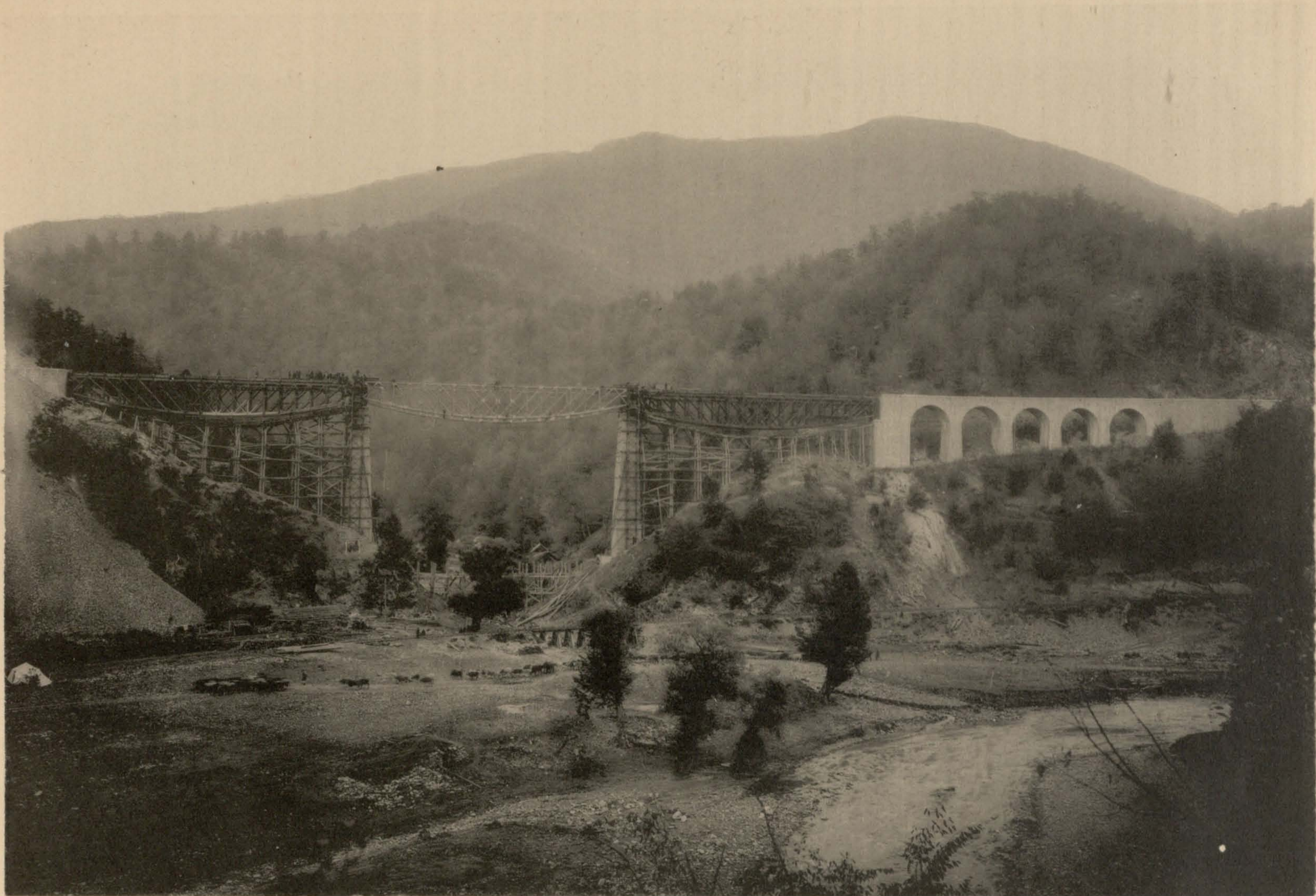
5) Фермы перемѣщены на опоры, но еще не связаны между собой.
