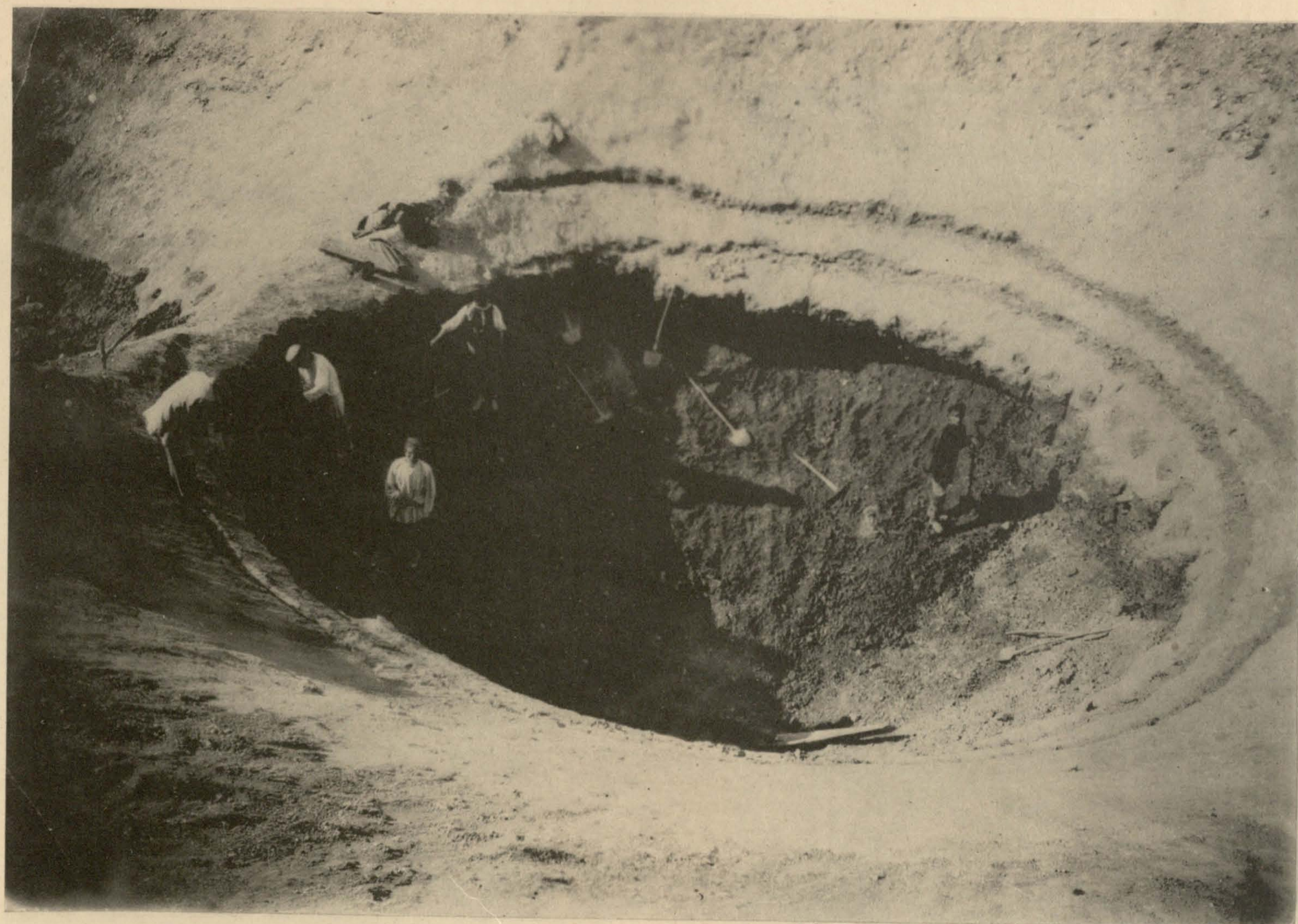
Разработка воронки при англійскомъ способѣ работъ въ западной выемкѣ.
