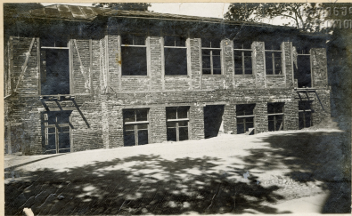
Капитальный ремонт шифондастройки Богжом) - 34г.
