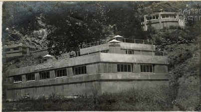
Канализация- очистительных сооружений 16 ступен - 28-29 год.
