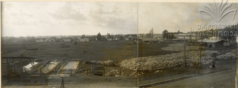
Строительство Дома Пресса -
