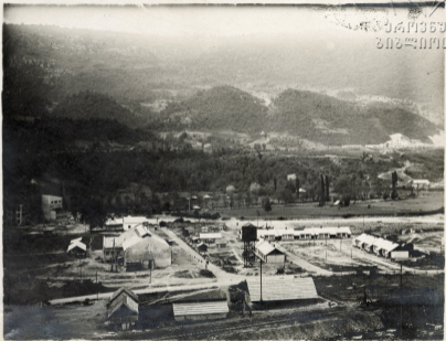
ТКВАРЧЕЛСТРОИ - Квезань-Электростанции 25/У1-34г. и жилпоселок электриков.
