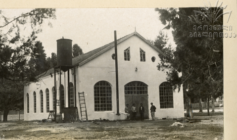
Новое здание Кобулетской электростанции
