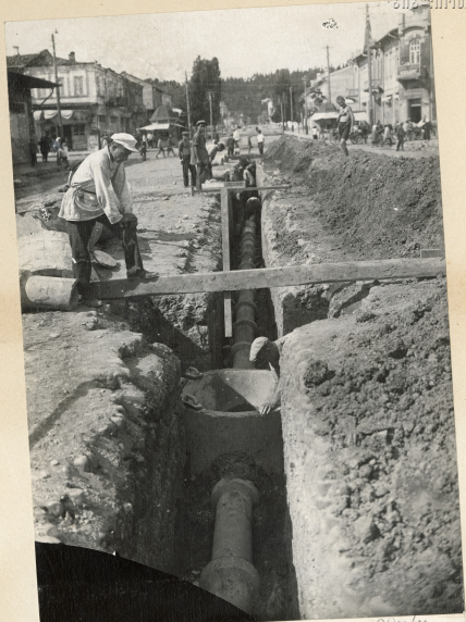
Прокладка уличной сети дм. 200м/м по ул. Фрунзе. - 1932г.
