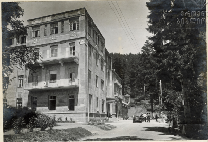
Санаторий Арзиндо- 2-й фасад Абхазети 34г
