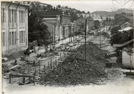
Стройсектор Сухумского Горсовета. Постройка Канализации в г. Сухуме /Укладка труб глав- ной магистрали по ул. 4-го марта /1934г. Июнь.
