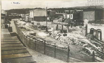
Вид строя площадки для постройки Ком.Гостиницы в момент сноса растворяющихся выходящих по ул.Брунзе, г. Сухум 15/VI-34г.
