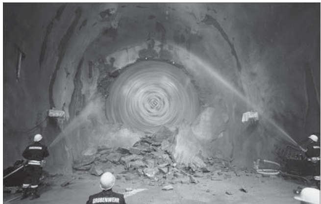
ნახ. 2. ფირმა “Herrenknecht AG”-ის გვირაბგასაყვანი მექანიზებული კომპლექსის საერთო ხედი (ა) და იგივე კომპლექსი მუშაობის პროცესში გვირაბების შეერთებისას (ბ)
