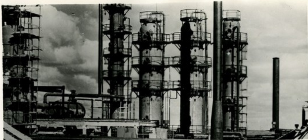
Рязань. На строительстве установки гидроочистки дизельного топлива нефтеперерабатывающего завода.
