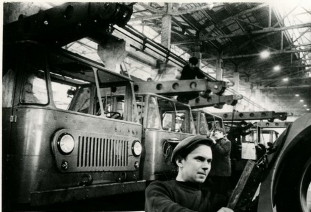
Иваново. Сборка новых малогабаритных автомобильных кранов.
