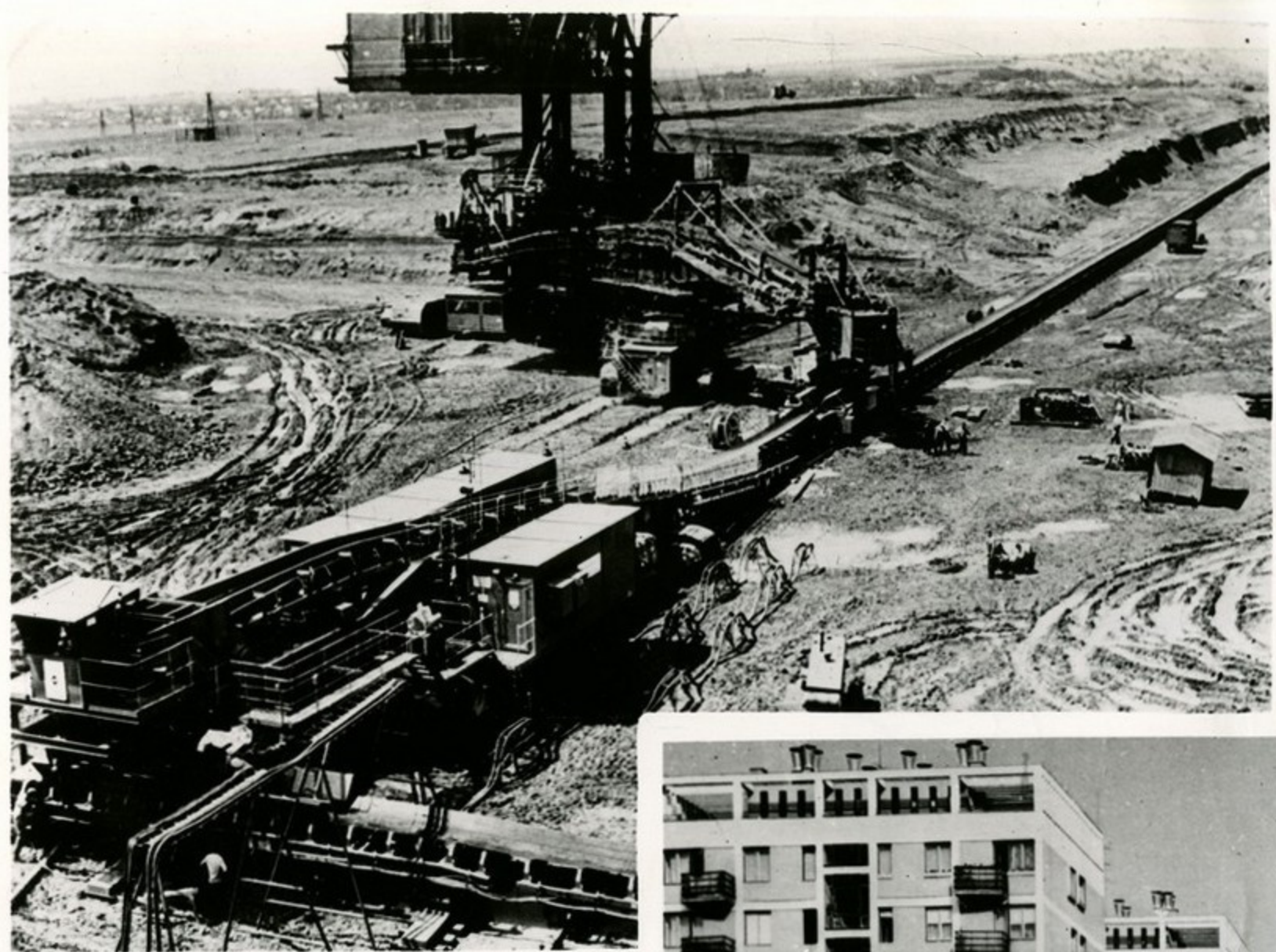
Мощные современные машины для производства вскрышных работ используются на открытых угольных разработках у подножья гор Матра.
