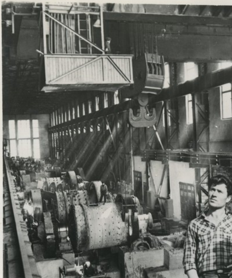
Монтаж новой шаровой мельницы
