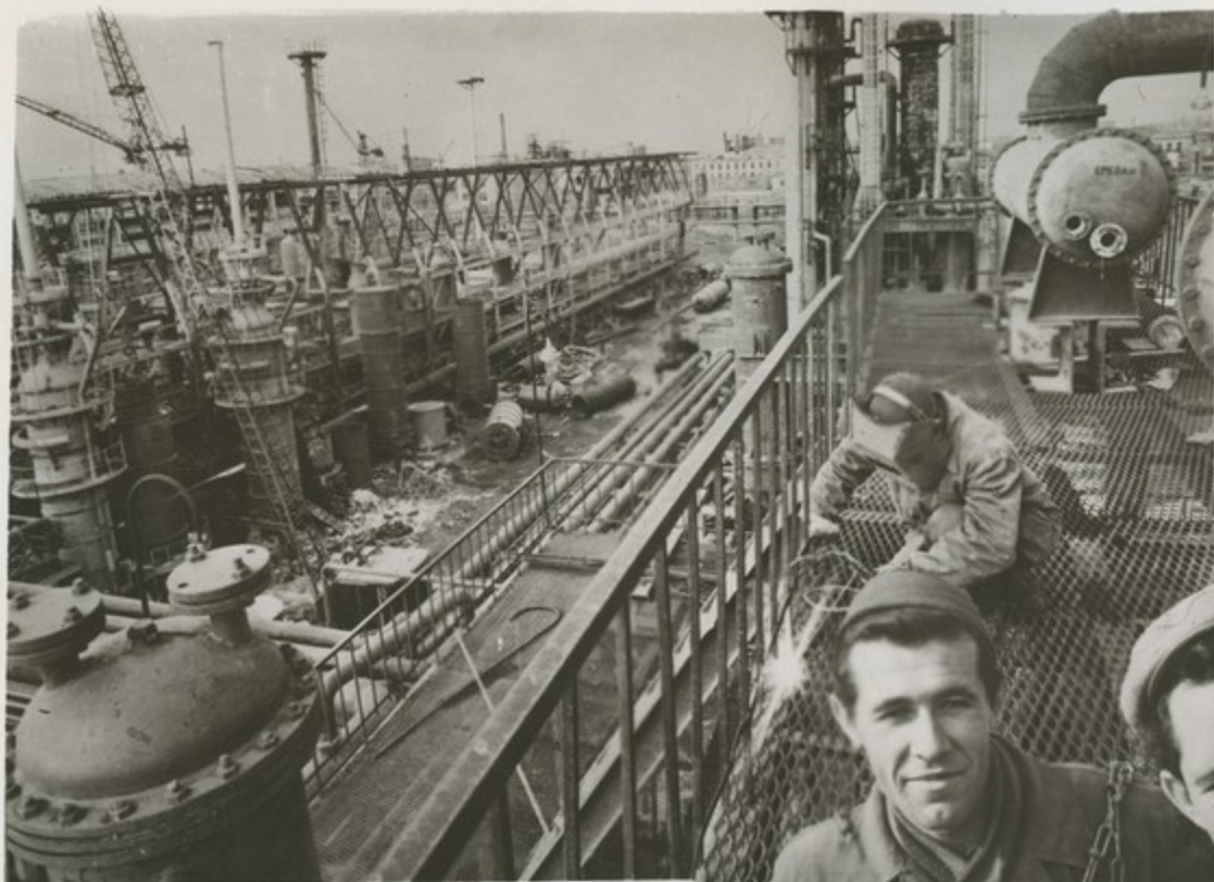
Общий вид строящегося комплекса по производству ацетилена
