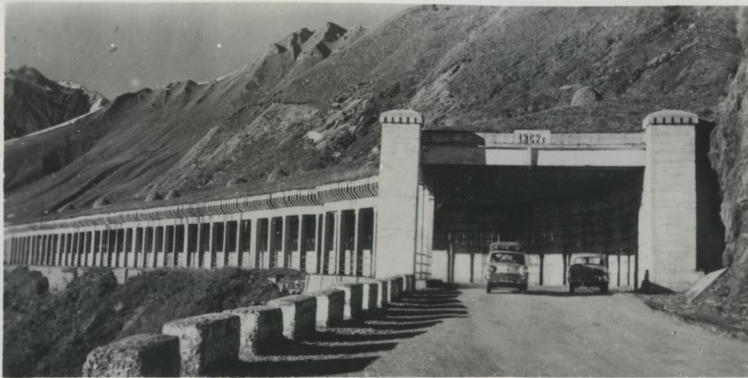
Наружный вид тоннеля.
