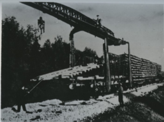
Укладка рельсов мощным путе- укладчиком.
