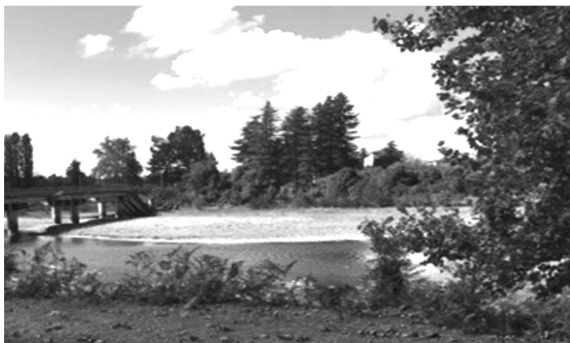
Фото 5. Закрытый соединяющий мост Орсанья-Меоре Отобая.
