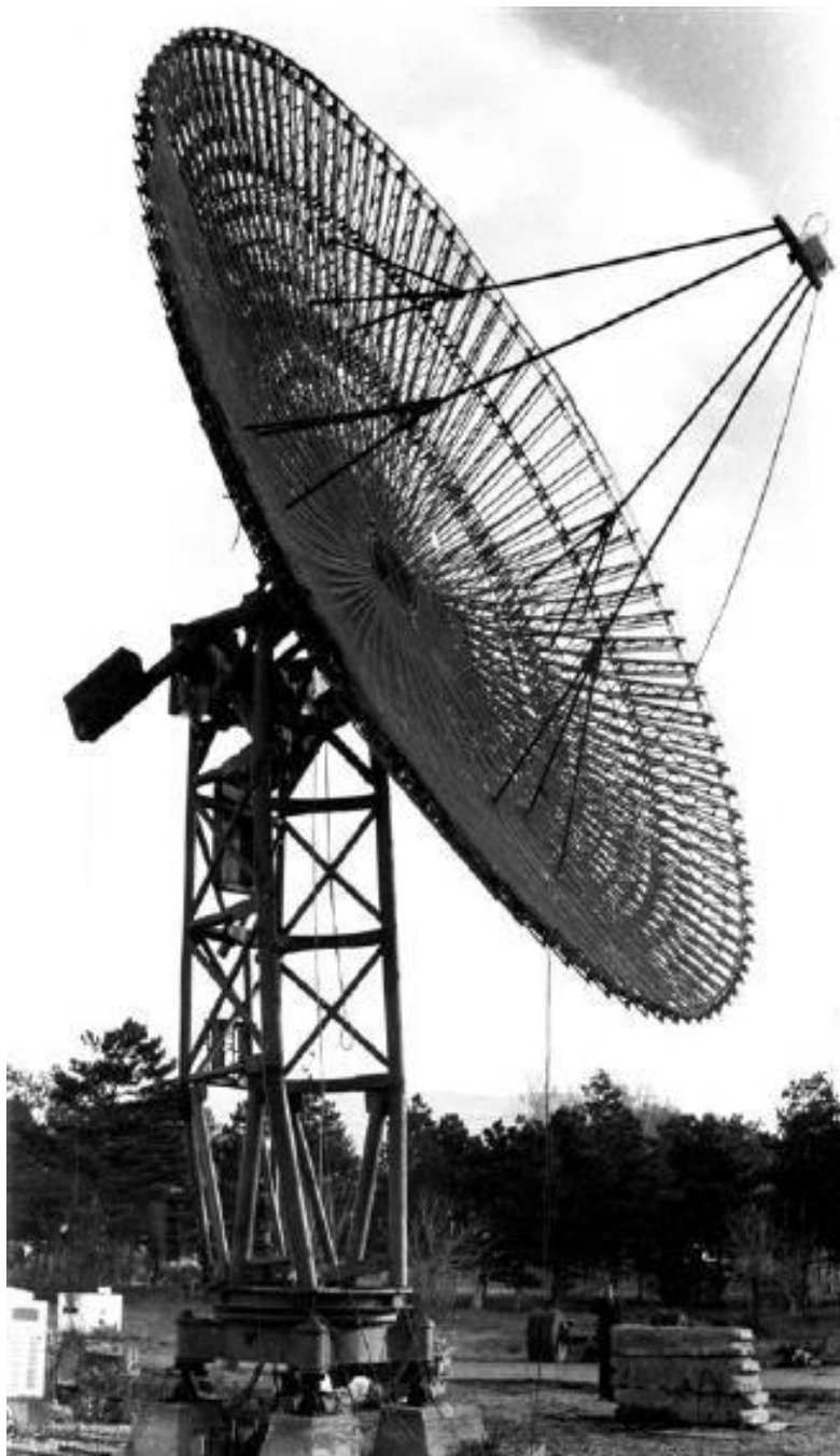
ფიგ. 25 – მექანიზებული რადიოტექნიკური საინჟინრო კომპლექსი, აგებული გასაშლელი, მბრუნავი, მაღალი სიზუსტის, მიწისზედა, 12 მეტრი დიამეტრის მქონე, რეფლექტორული ანტენის ბაზაზე.
