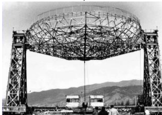
ფიგ. 22 – კოსმოსური რეფლექტორული ანტენის გაშლის სტენდიდან, რადიოტექნიკურ პარამეტრებზე შემოწმების, მბრუნავ სტენდზე გადატანის ეტაპები:
