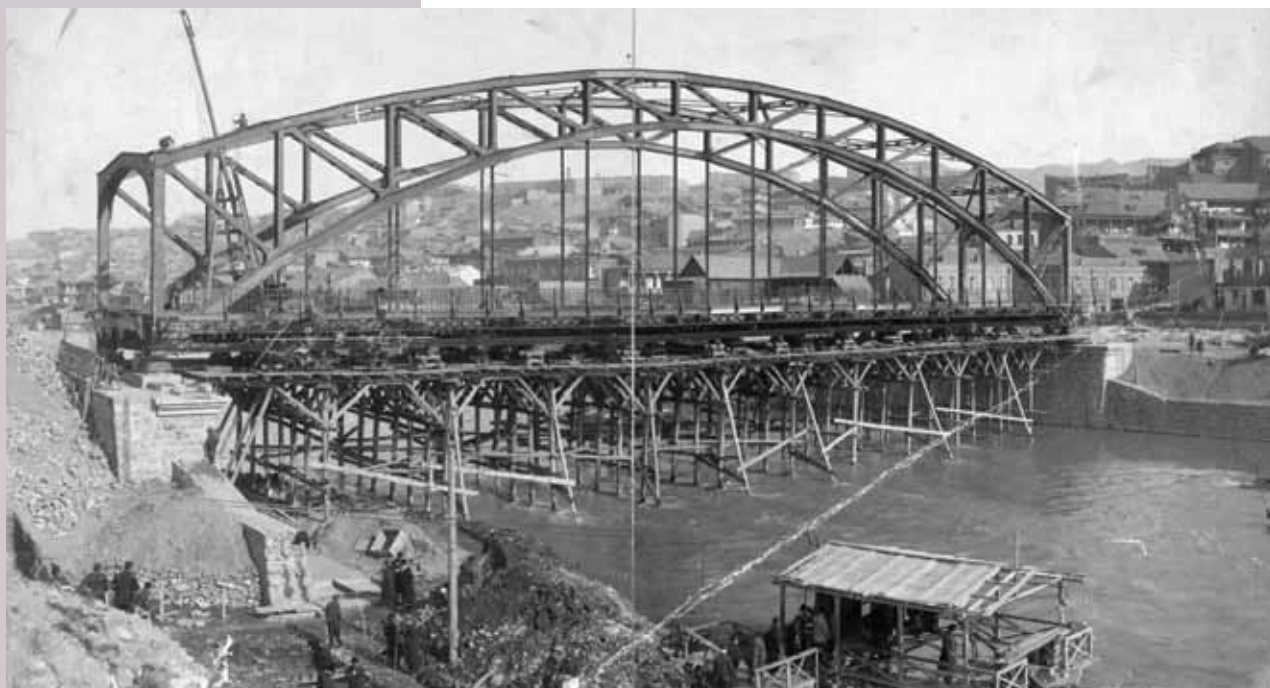
Строительство Мухранского моста
