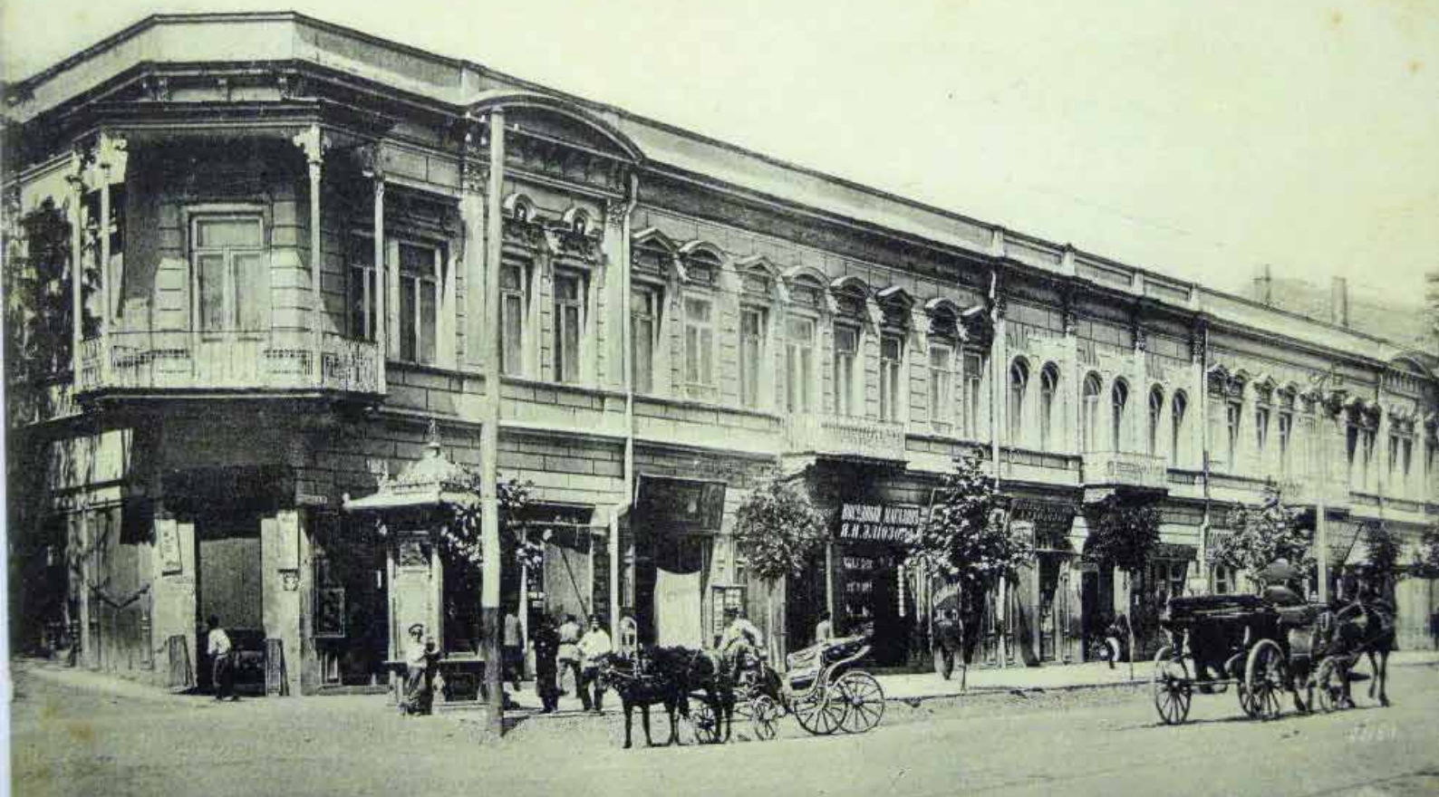
Дом Шиоевых на углу Головинского проспекта и Давидовской улицы
