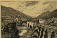
Мидхетский мостъ на рѣкѣ Къра,
