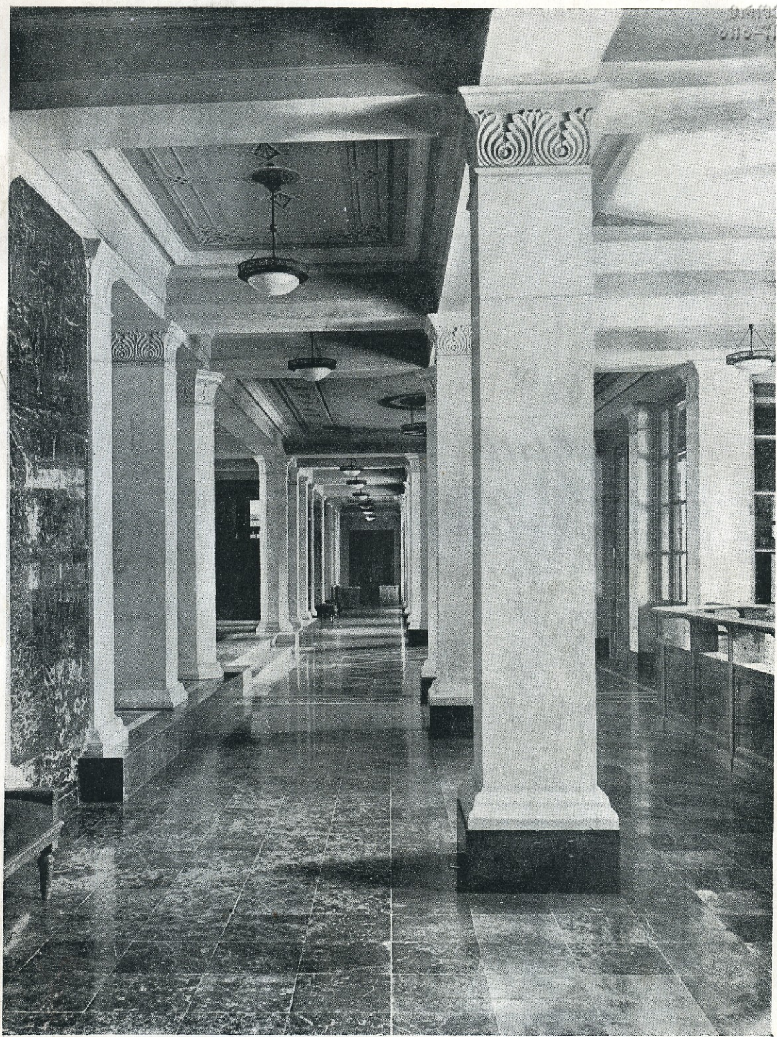
22. Коридор 1-го этажа
