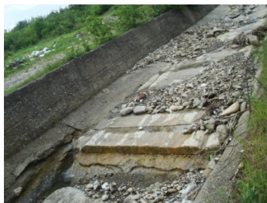
სურ. 4. ანტისანიტარია და ბეტონის დეფორმირებული კალაპოტი
