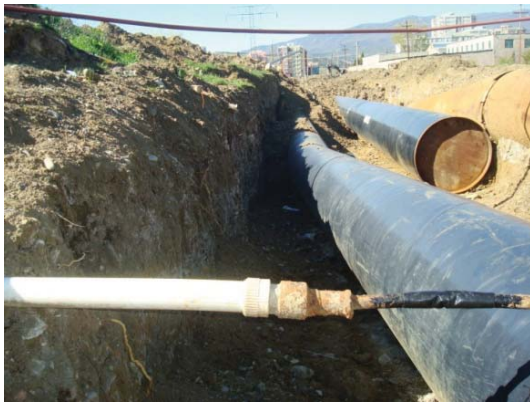
ძველი ამორტიზებული მილსადენი თურქული წარმოების ახალი მილსადენი
