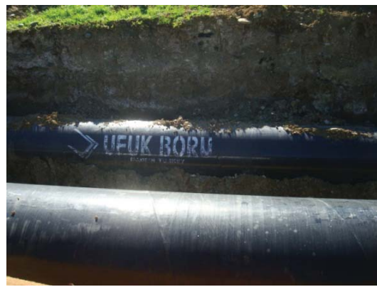
ძველი ამორტიზებული მილსადენი თურქული წარმოების ახალი მილსადენი
