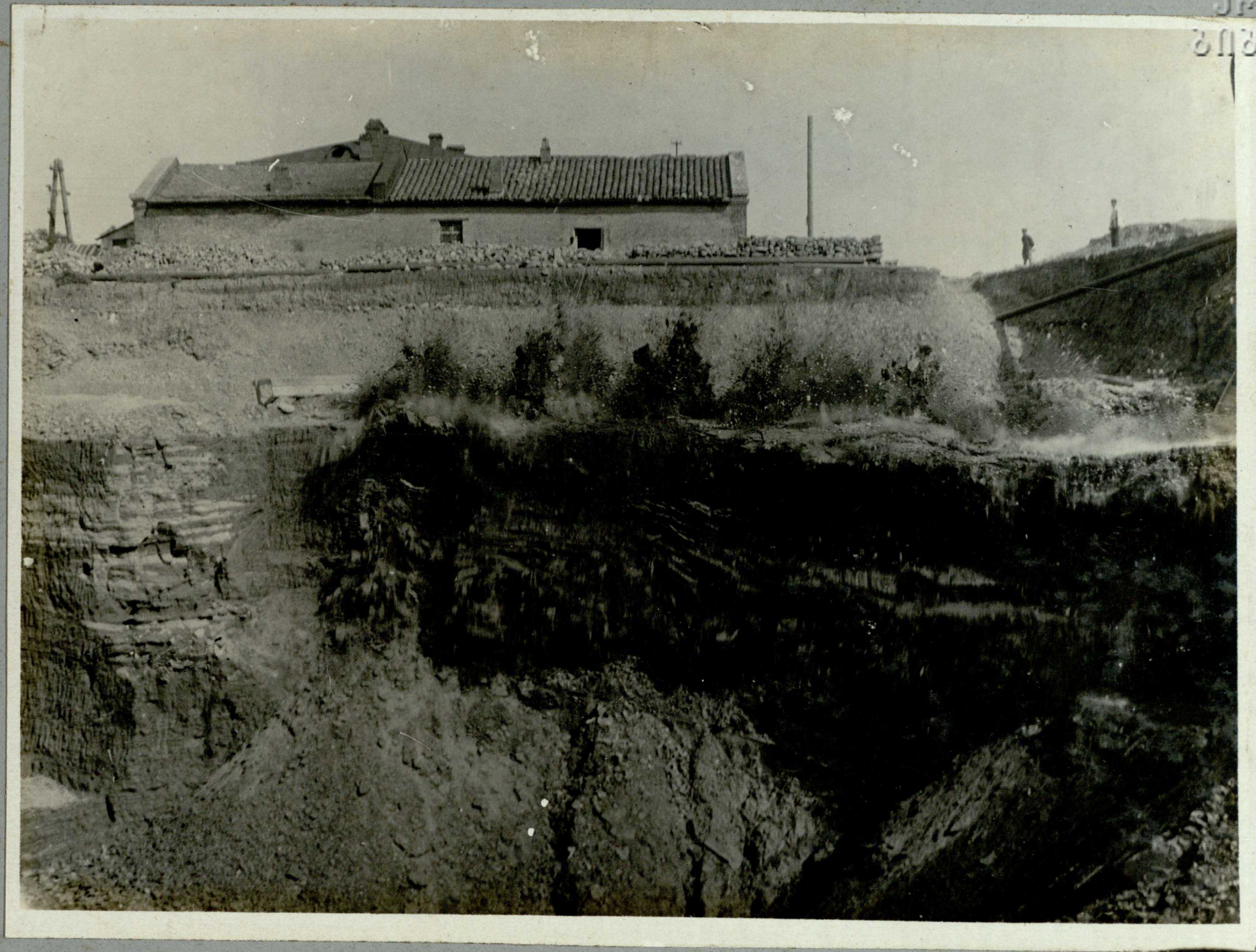
Разработка выемки глинистого грунта взрывами. 1/VII—1934 г.
