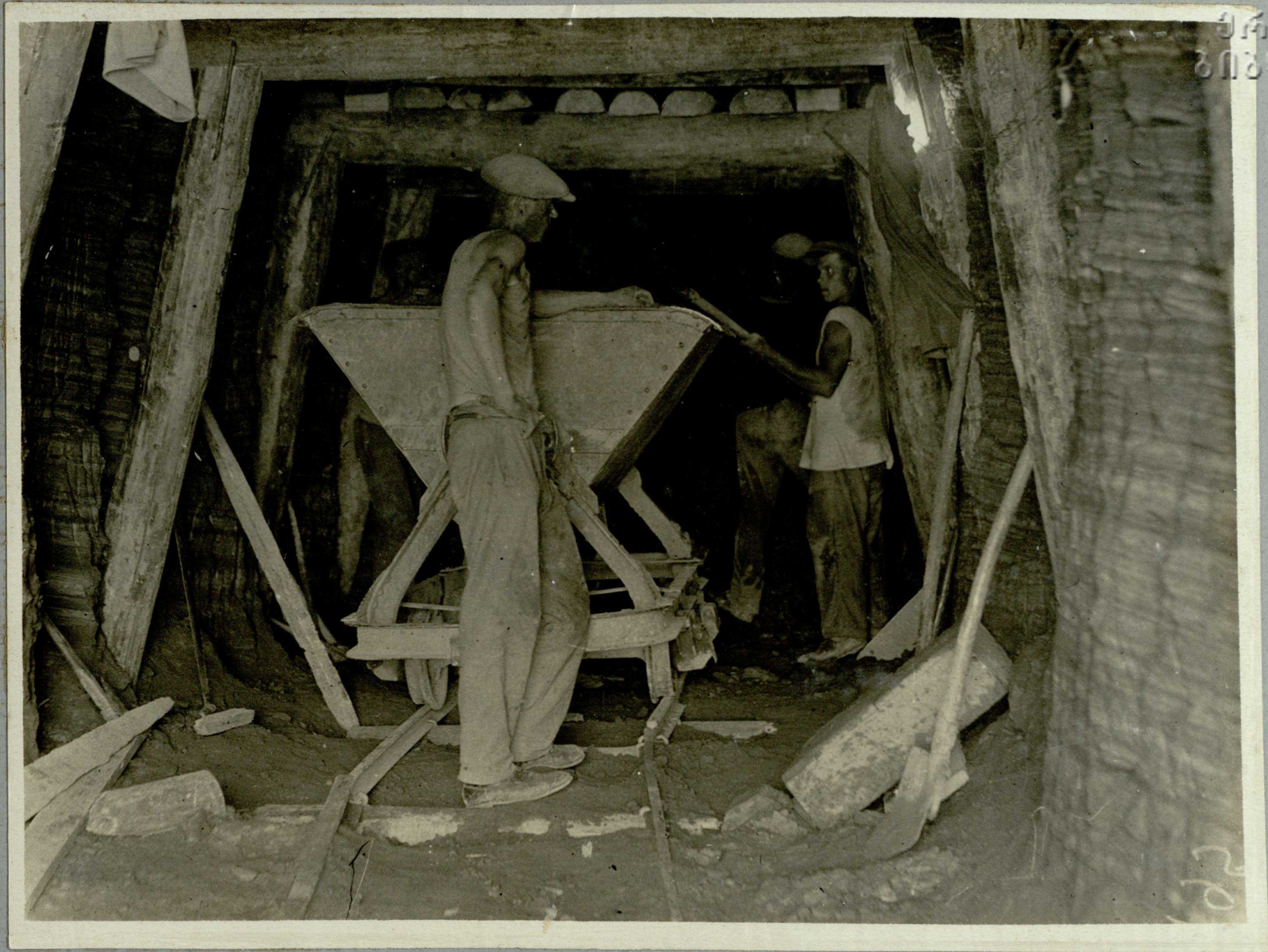
Тоннельная разработка выемки. 20/XII—1934 г.
