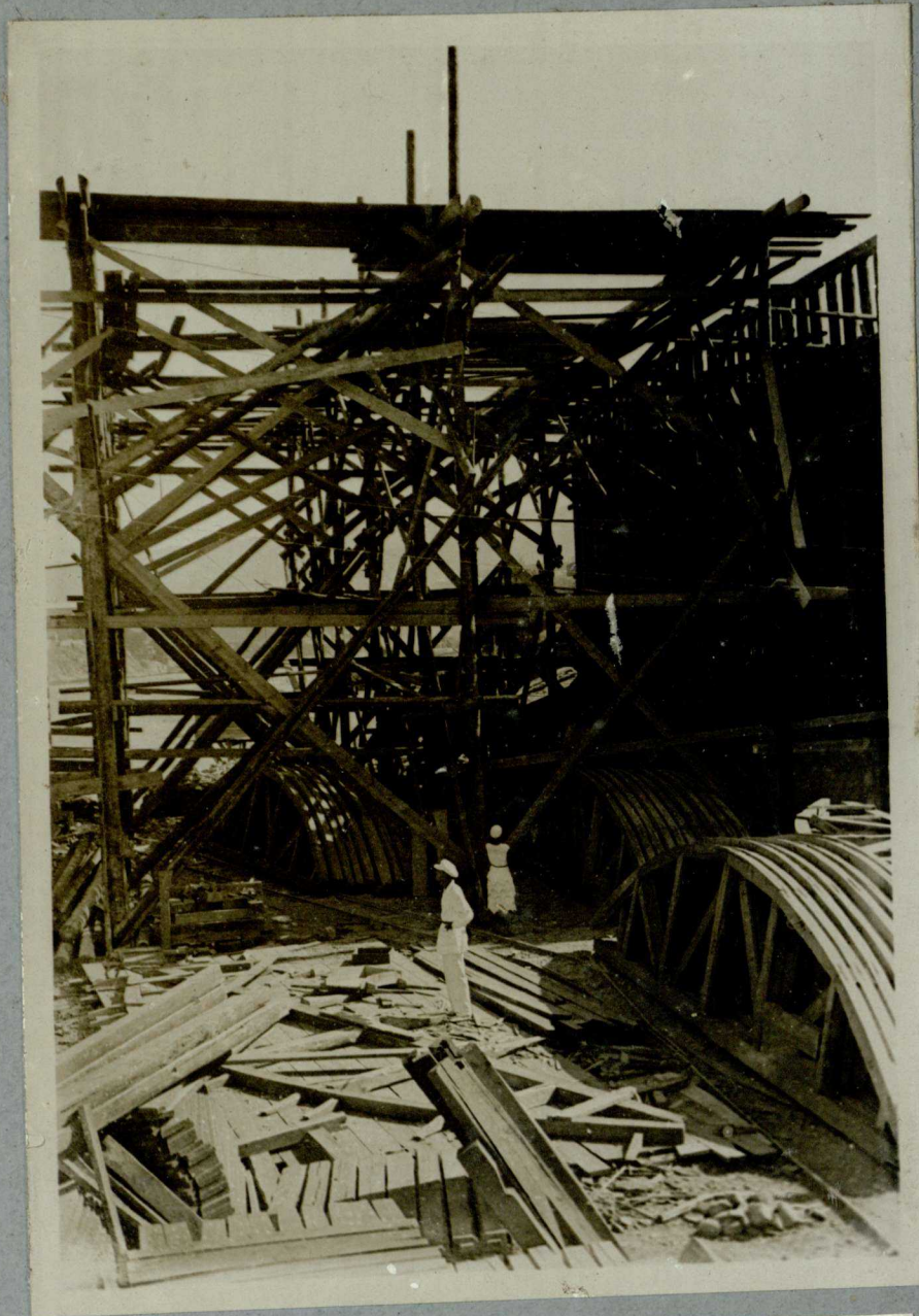
Заготовка кружал и подмости для установки берегового про- лета. 5/IX—1933 г.
