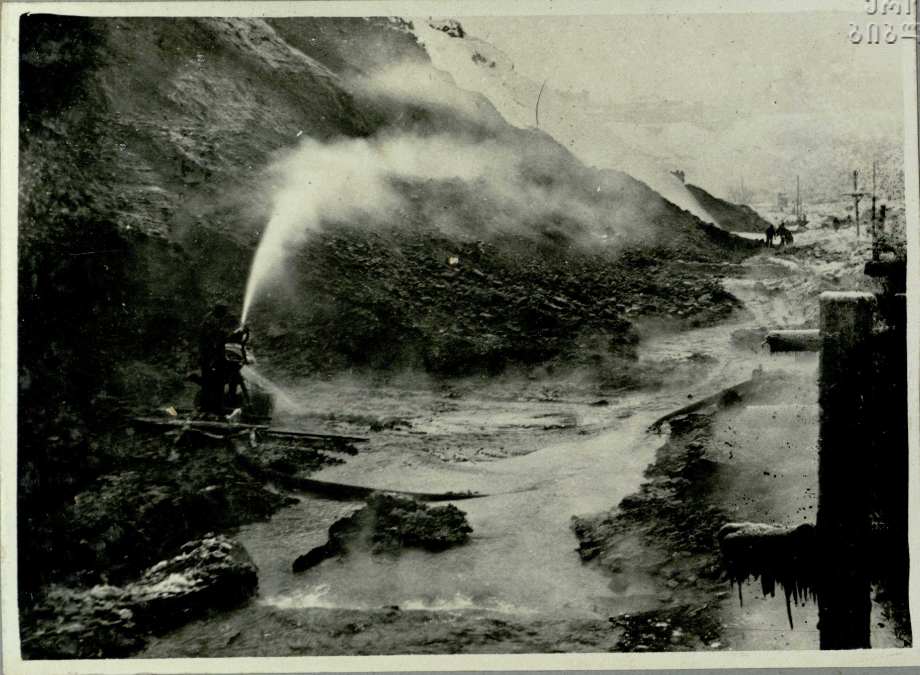
Работа монитора зимой при морозе 18^{\circ}\text{C} . 23/1—1935 г.
