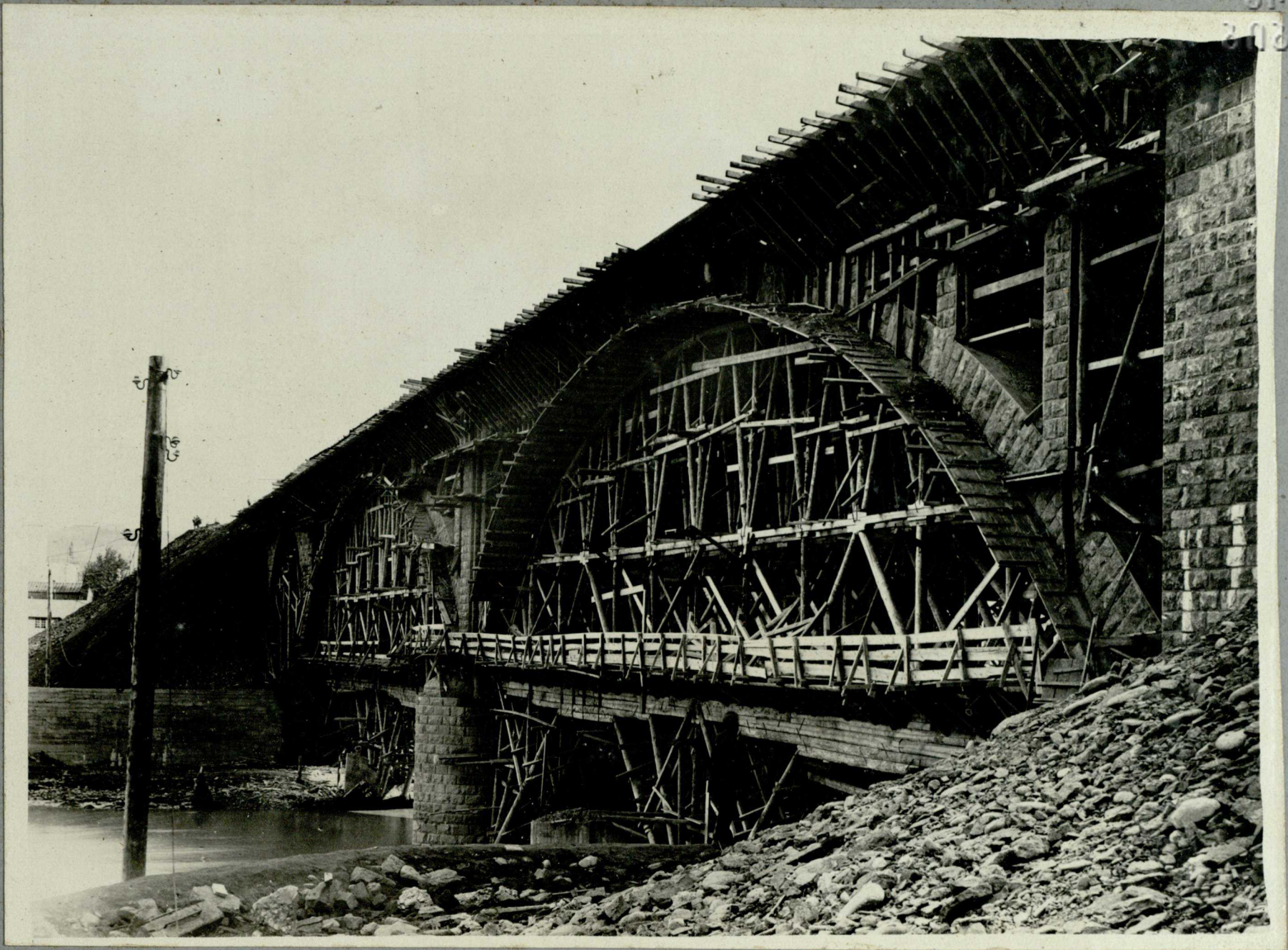
Разборка опалубки консолей тротуара моста. 13/XII—1934 г.
