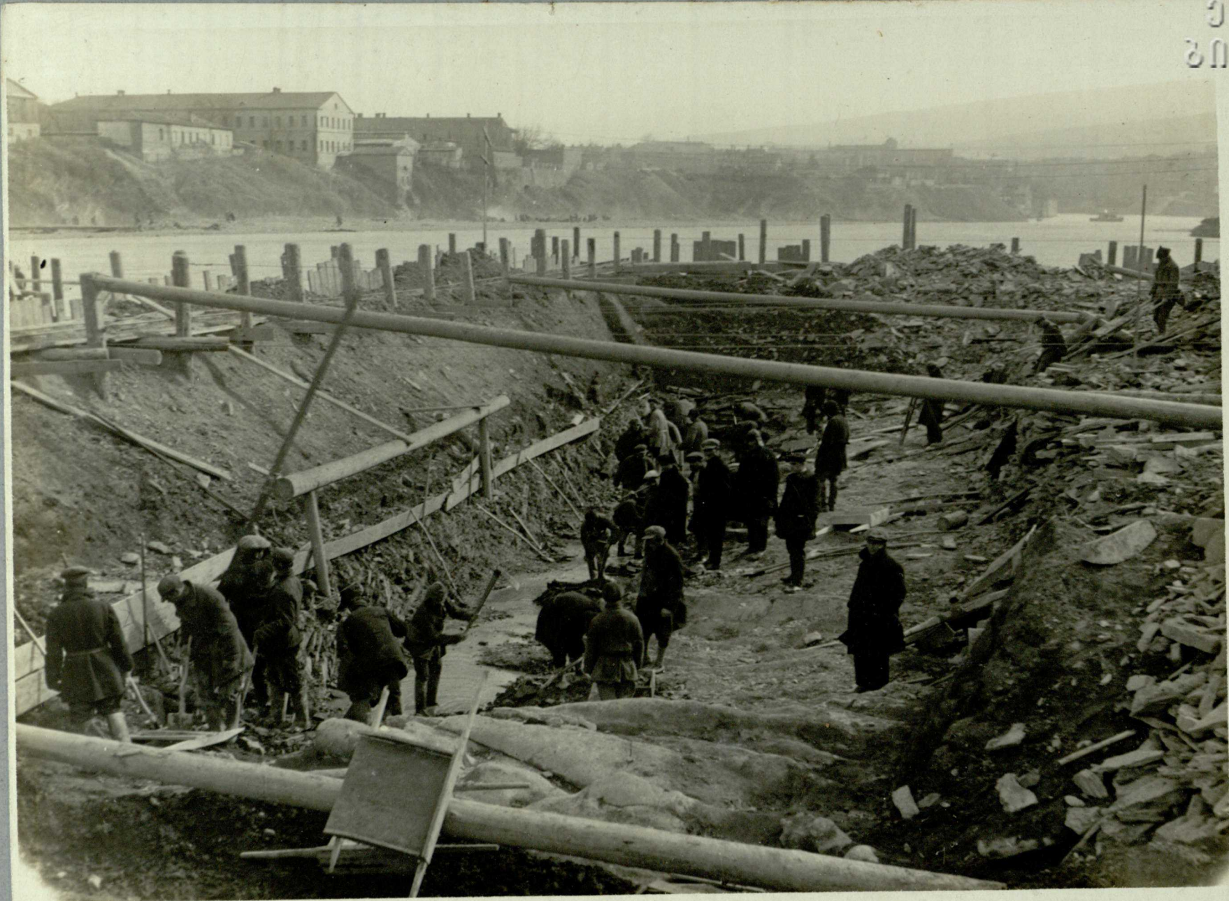
Котлован опоры № 4. 21/II—1933 г.
