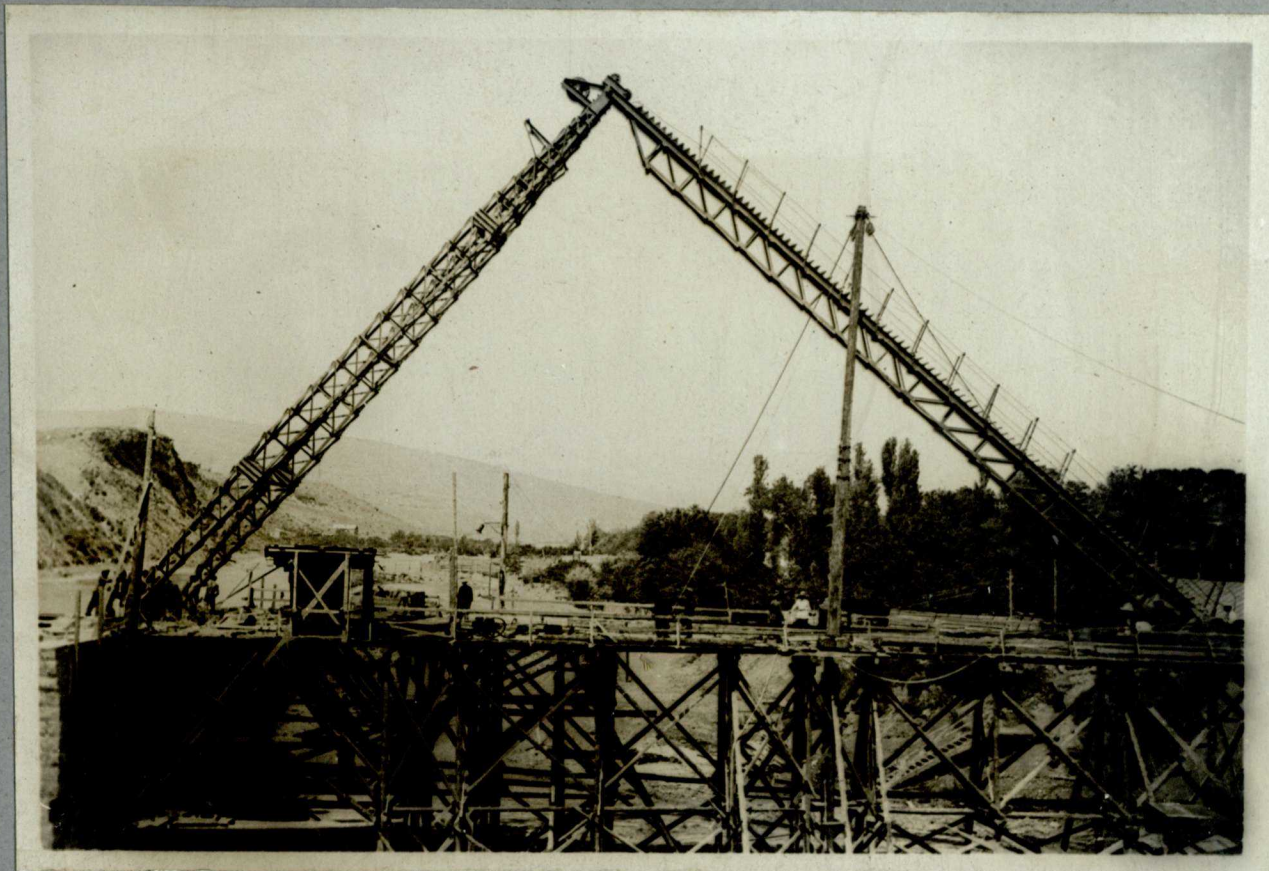
Под'ем металлической опоры канатного крана. 1/VIII—1932 г.
