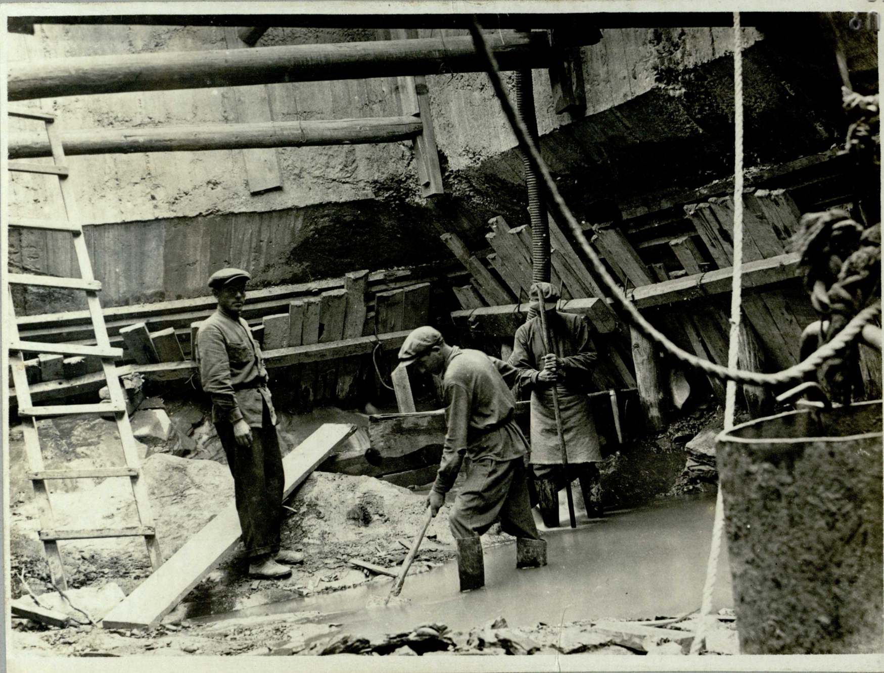
Котлован опоры № 2. 25/X—1932 г.
