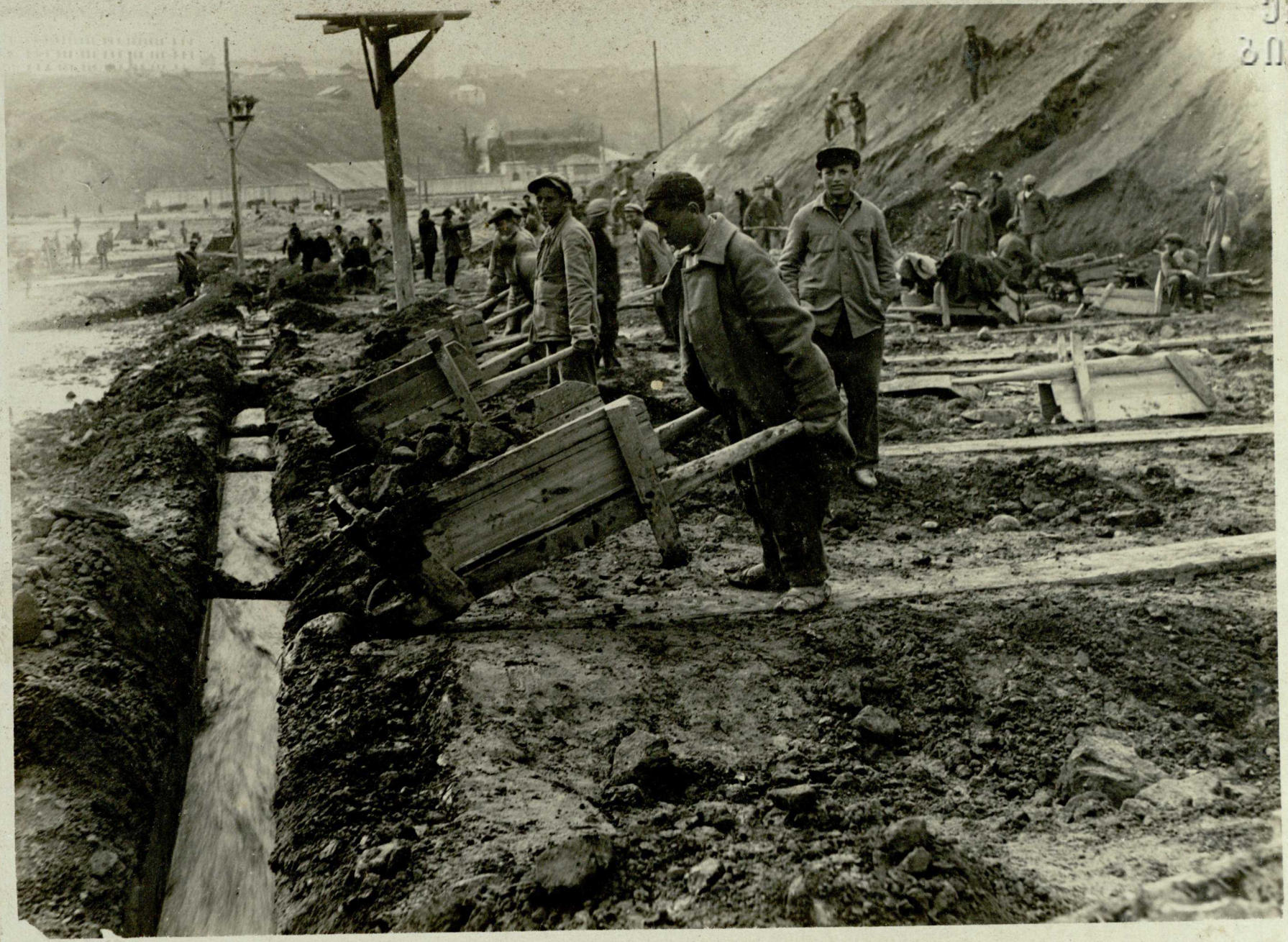
Гидромеханизация земляных работ на выемке. Транспортировка грунта водой по желобу. 24/II—1935 г.
