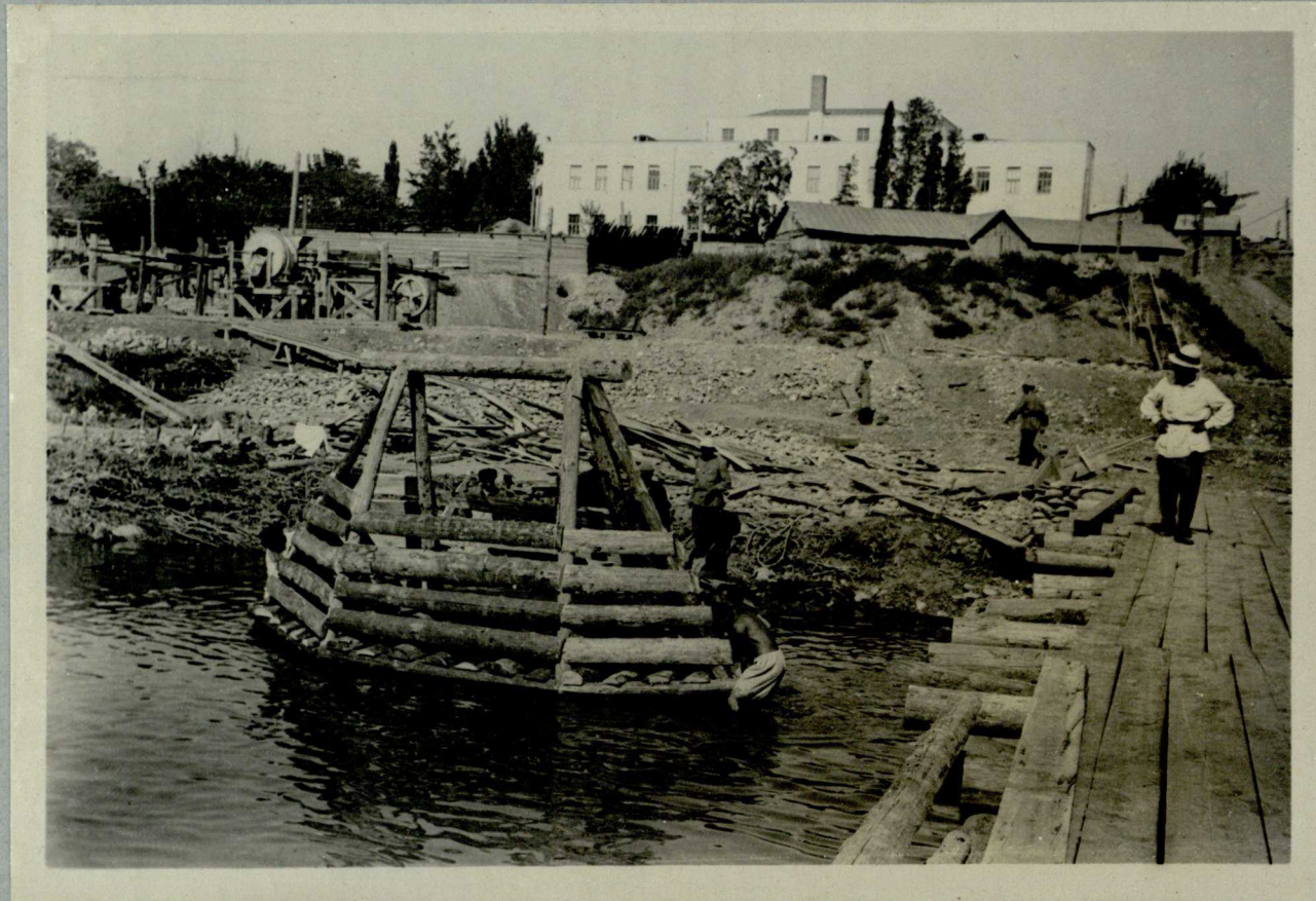
Временный мост. Установка опор. 20/VIII—1932 г.
