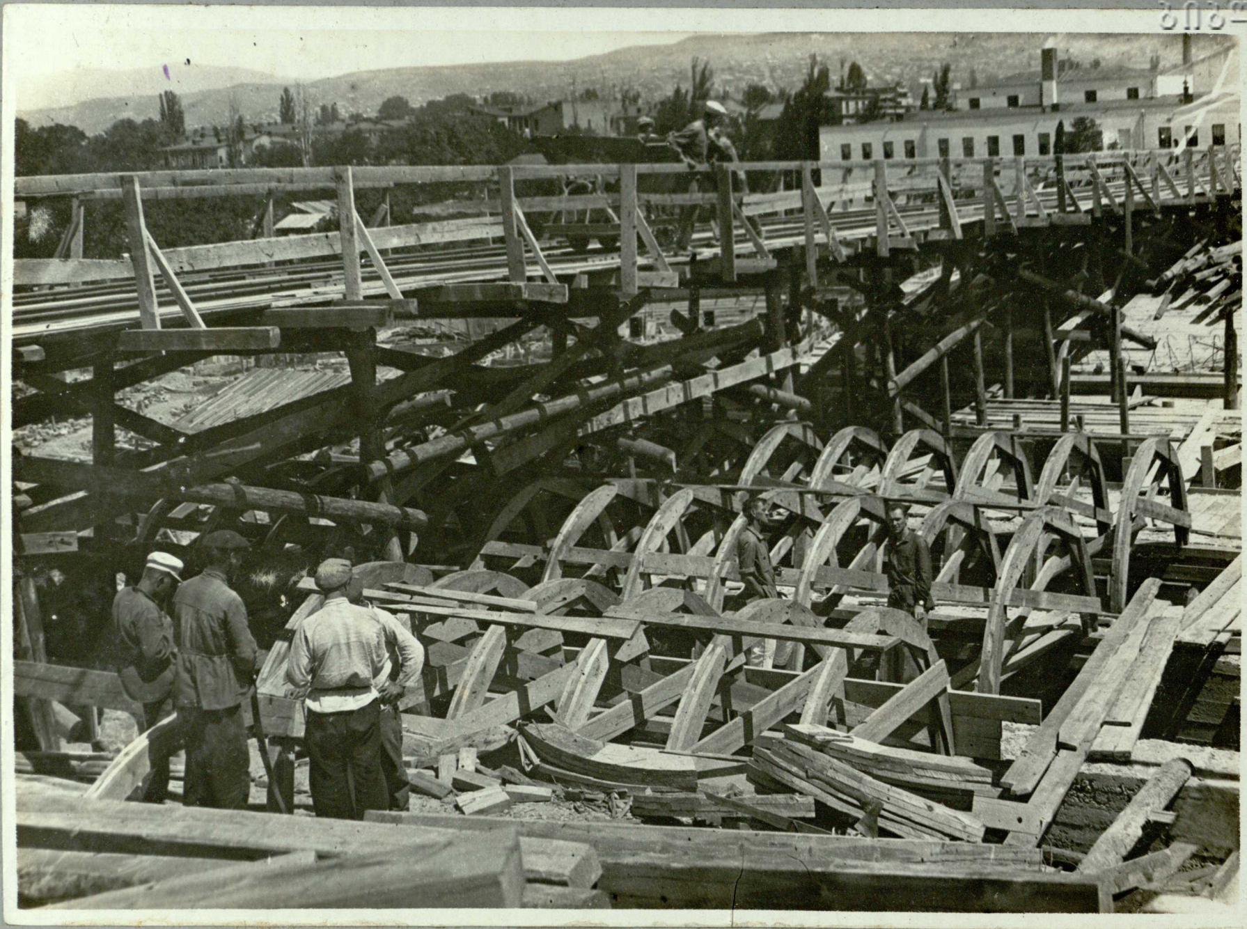
Установка кружал надсводной эстакады. 9/VIII—1934 г.
