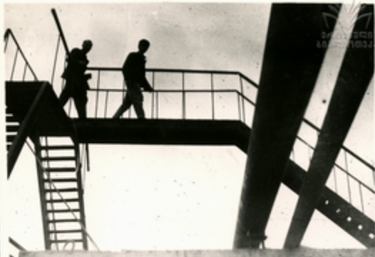
Строительство цеха карбамида
